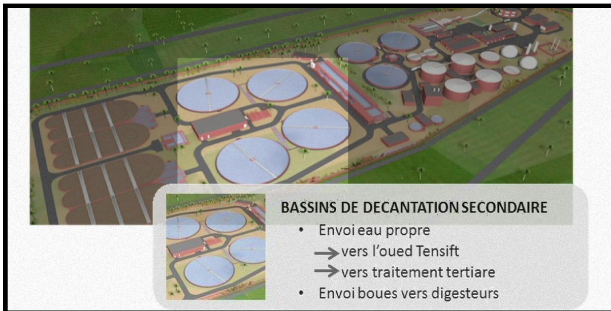
Fig. 8 : décantation secondaire
