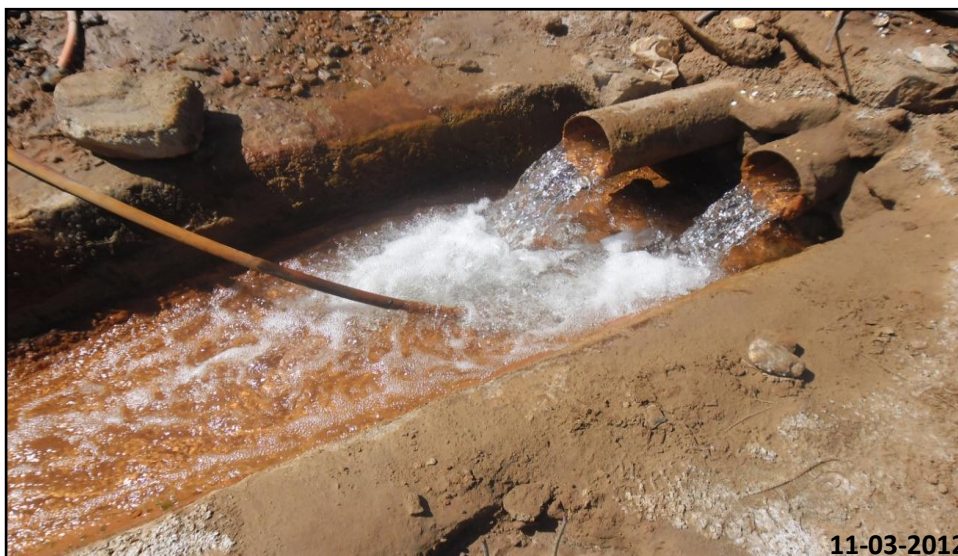
Figure 40 : Buse d'eau n°1 à Bounhass
