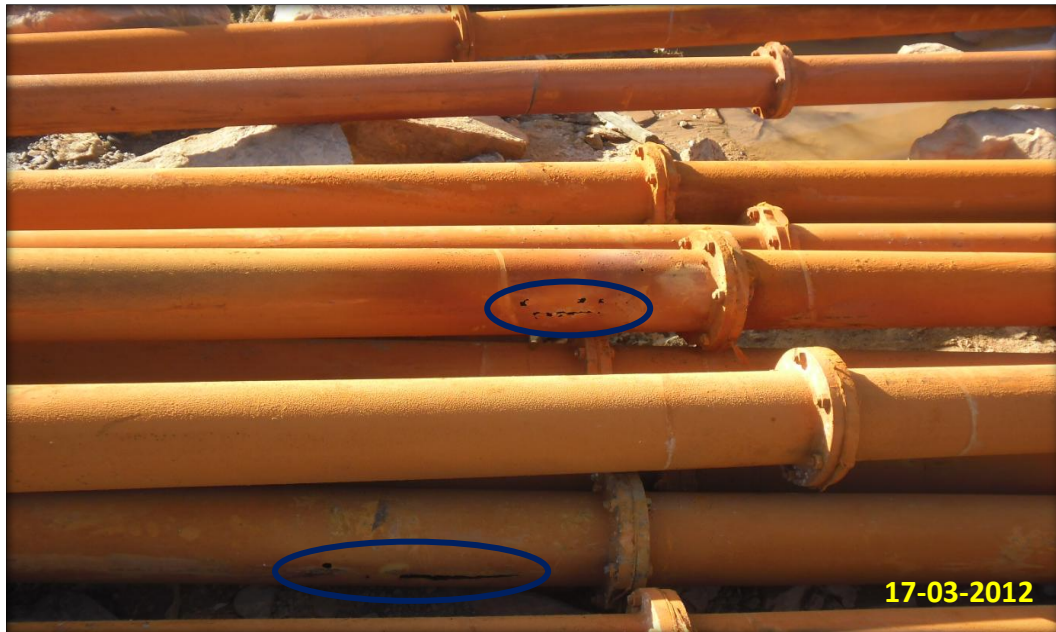
Figure 16 : Conduites rouillées et corrodées à Bounhass
