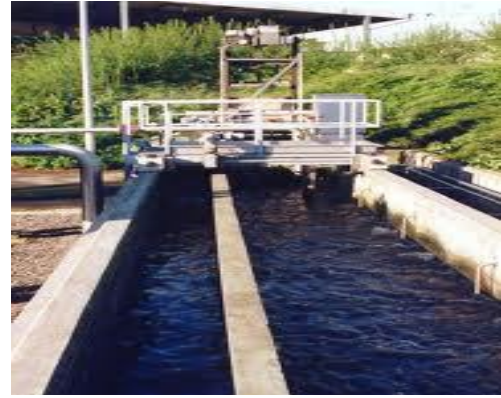
Figure 9 : Photo d'un dessableur
