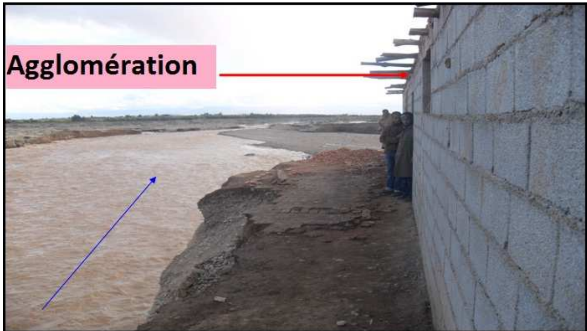
Ph.IV-7: Photos montrant la déviation du cours d'eau N'Fis vers la rive gauche lors de la crue 2006, montrant l'érosion des sols de la berge
