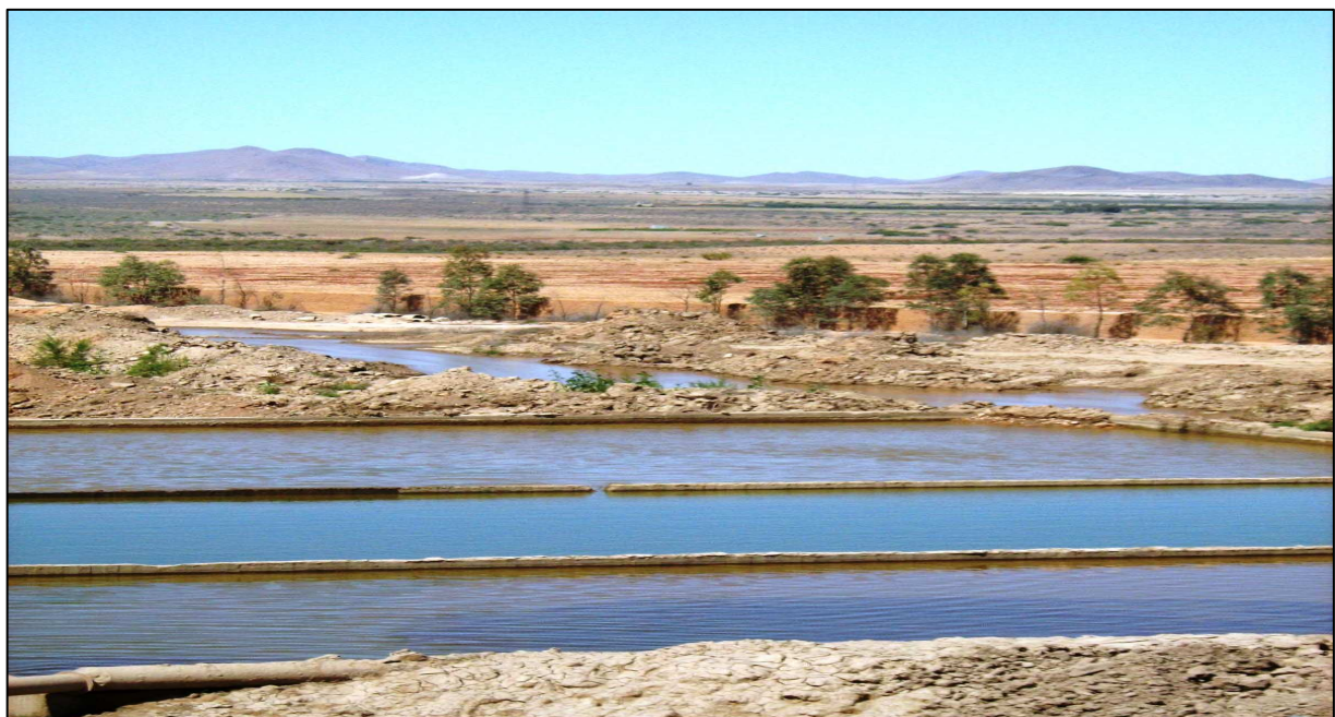
Ph.III-12 : Exemple d'unité de clarification sans filtre et avec bassins de décantation
