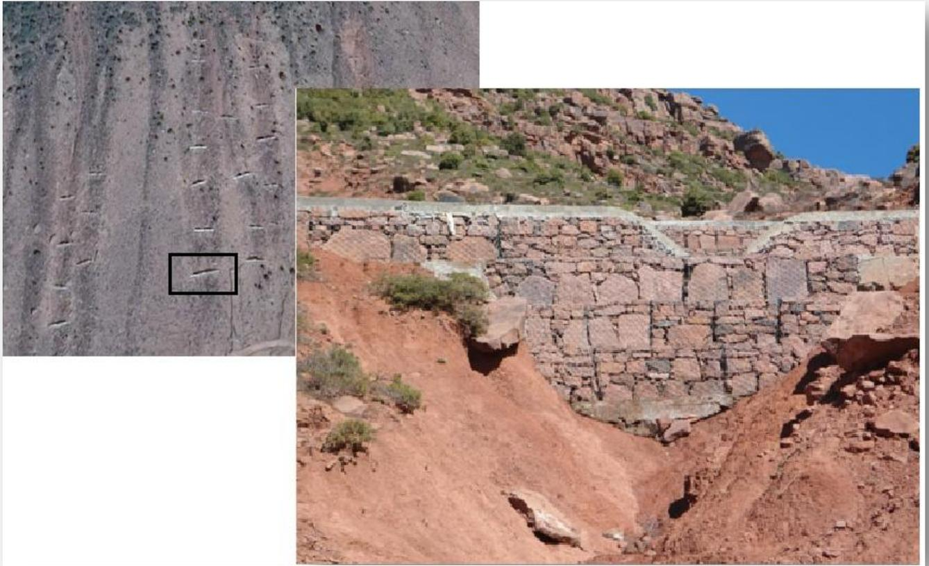
Figure 30: Photo montrant le détail d'un seuil en gabion
