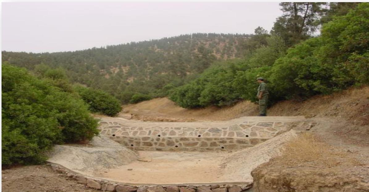
Figure 9: Seuil en maçonnerie
