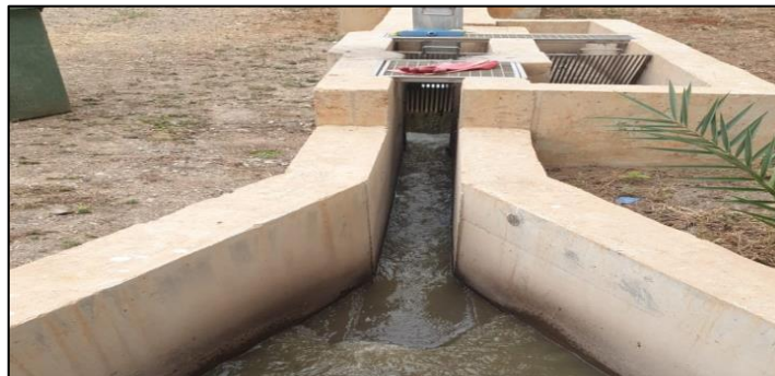
Figure 15 : Canal dégrilleur-dessableur
