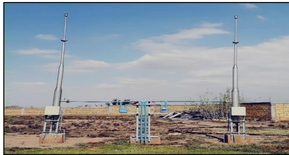
Figure 30 : installation du traitement UV
