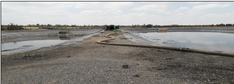
Figure 16 : Les deux bassins anaérobies
