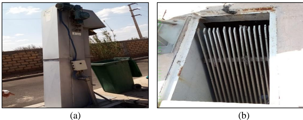
Figure 24 : dégrilleur-dessableur-déshuileur automatique (a) et manuel (b)
