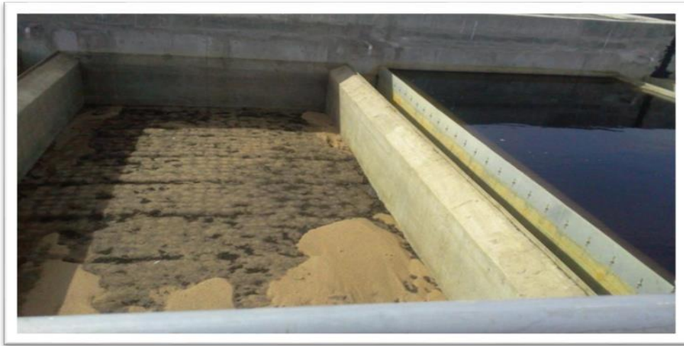
Photo 7: photo illustrant un exemple de filtre à sable dans la STEP étudiée.
