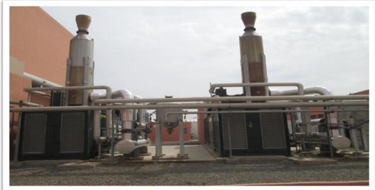
Photo 12: photo montrant un exemple de cogénération de la STEP de Marrakech étudiée.
