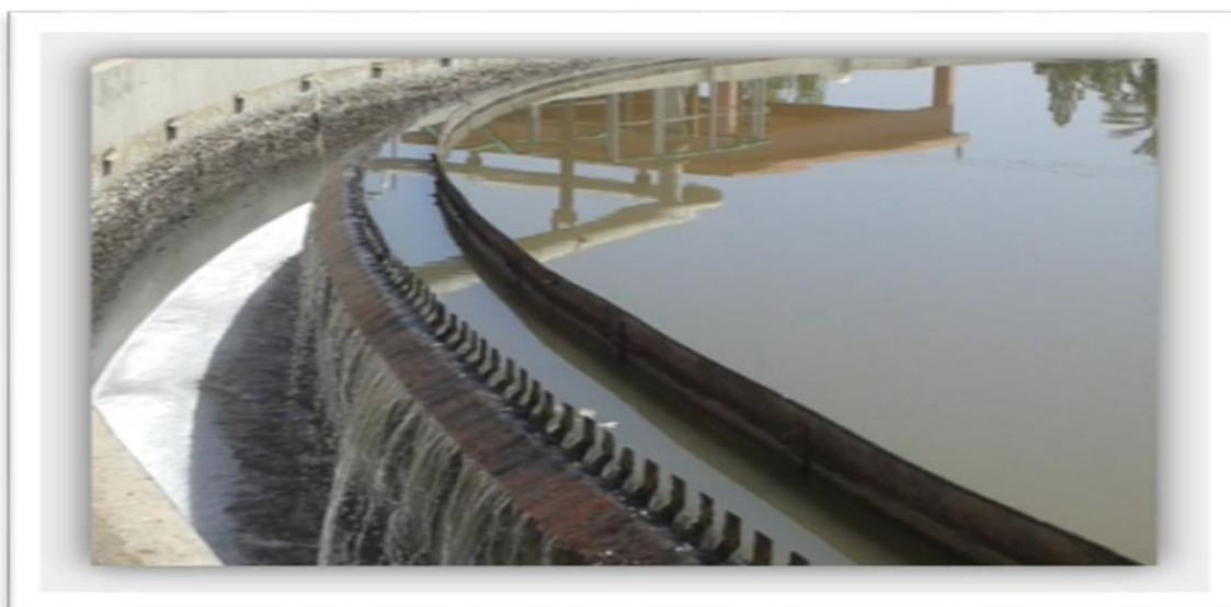
Photo 6: photo illustrant un exemple de clarificateur dans la STEP étudiée.
