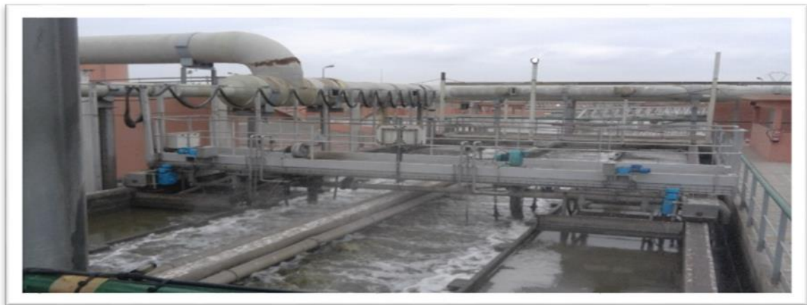
Photo 4: photo montrant le dispositif dessableur-déshuileur
