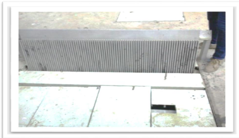
Photo 3: dégrillage fin
