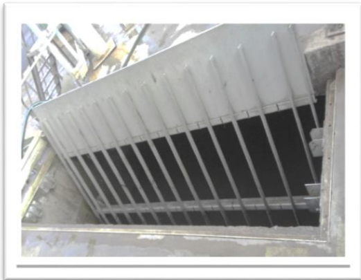
Photo 1: Pré-grille à l'entrée de la STEP
