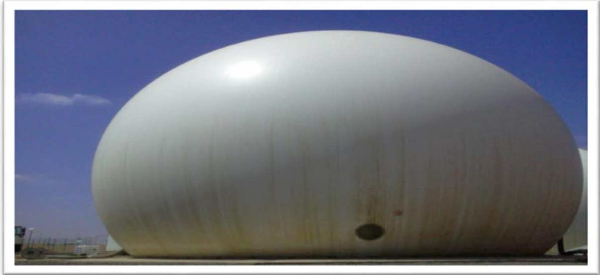
Photo 11: photo montrant un exemple de gazomètre de la STEP de Marrakech.
