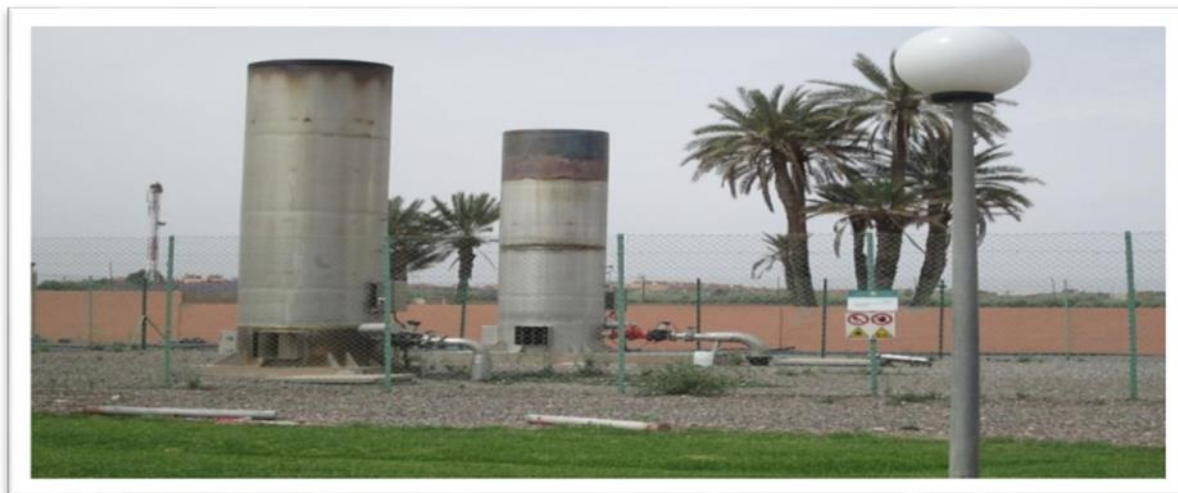
Photo 13: exemple de torchères qui servent pour la combustion du gaz au niveau de la STEP étudiée.
