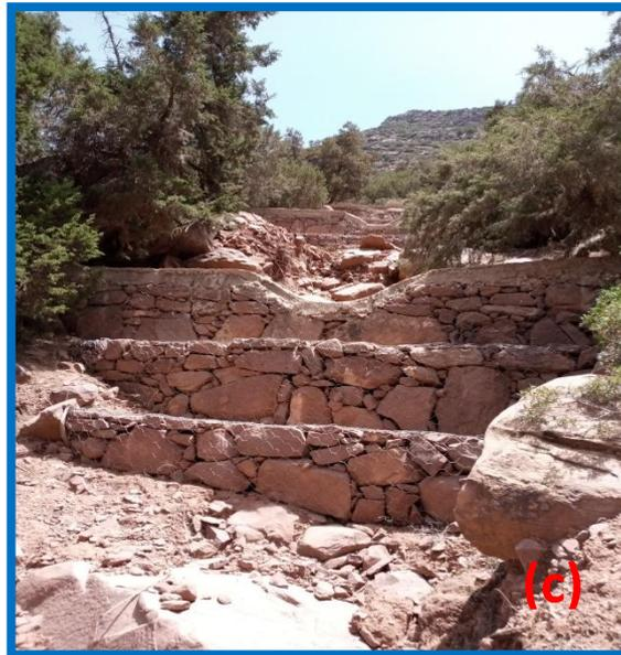
**Figure 3:** (a); Seuil en pierres sèches, (b); Seuils en maçonneries, (c); Seuils en gabions
