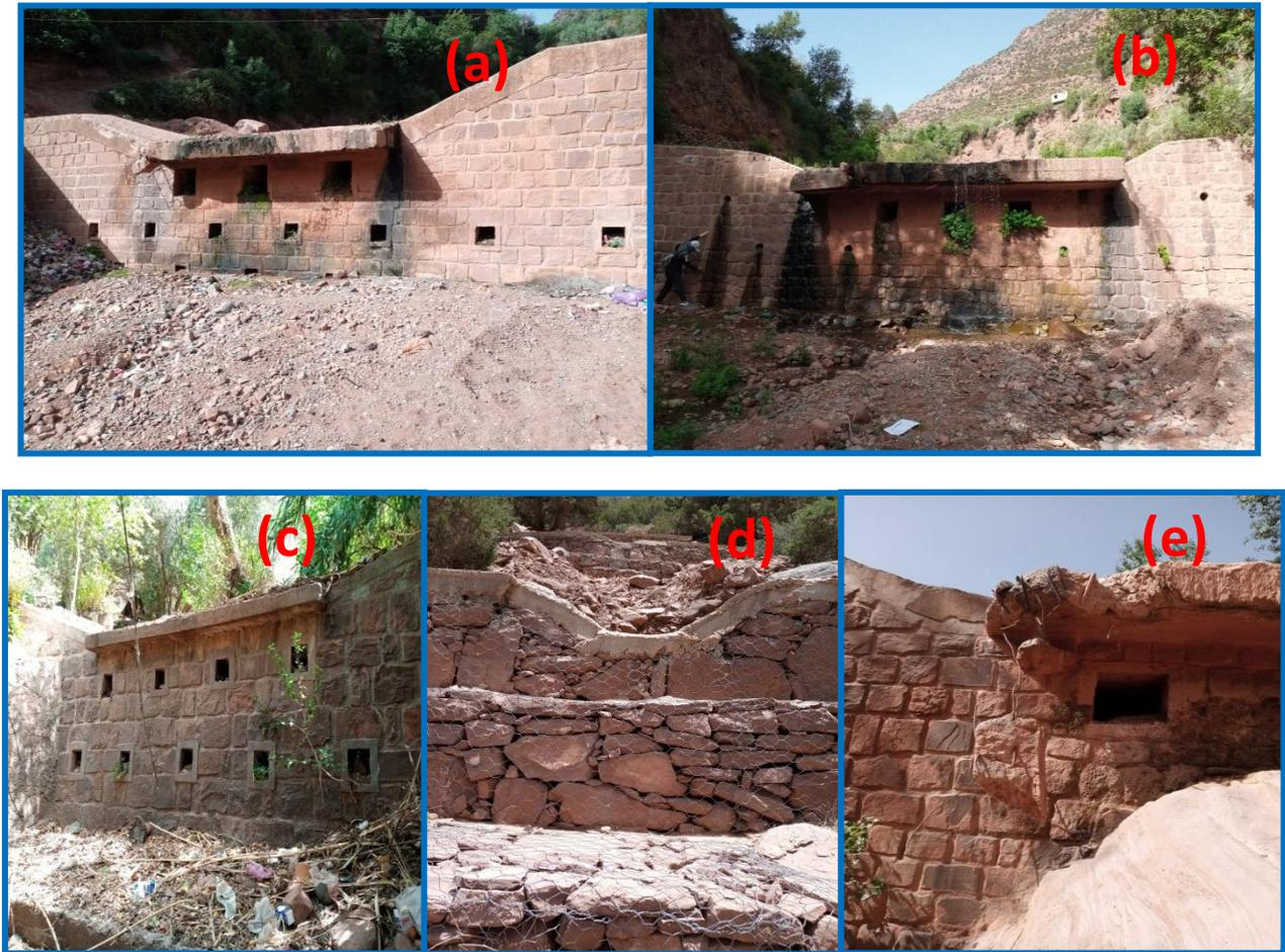
**Figure 20:** : (a) : Seuil1 en maçonnerie du ravin 1, (b) : Seuil2 en maçonnerie du ravin 1, (c) :Seuil 2 en maçonnerie du ravin 2, (d) : seuils en gabion du ravin 3, (e) : Déversoir endommagé du seuil 3 du ravin1
