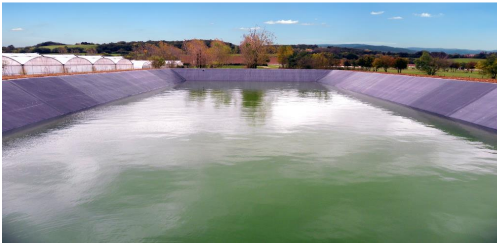
Figure 5: Bassin d'irrigation (catégorie : stockage en géomembrane)
