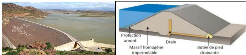
Figure 2 : Barrage en terre homogène
