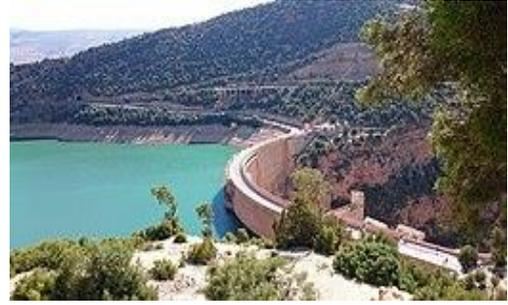
Figure 2 : Exemple du barrage voûte au Maroc (Barrage Bin el Ouidane, province d'Azilal)
