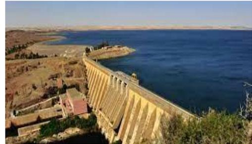
Figure 4: Exemple du barrage poids (Barrage al Massira)
