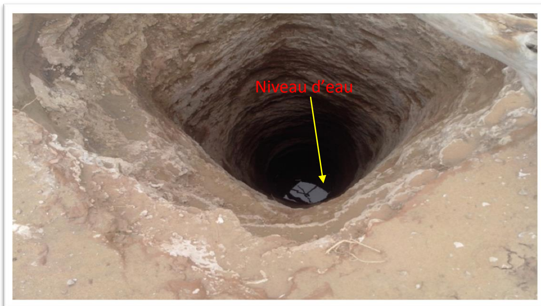
Figure 20 : photo d'un puits qui montre la profondeur de la nappe phréatique.
