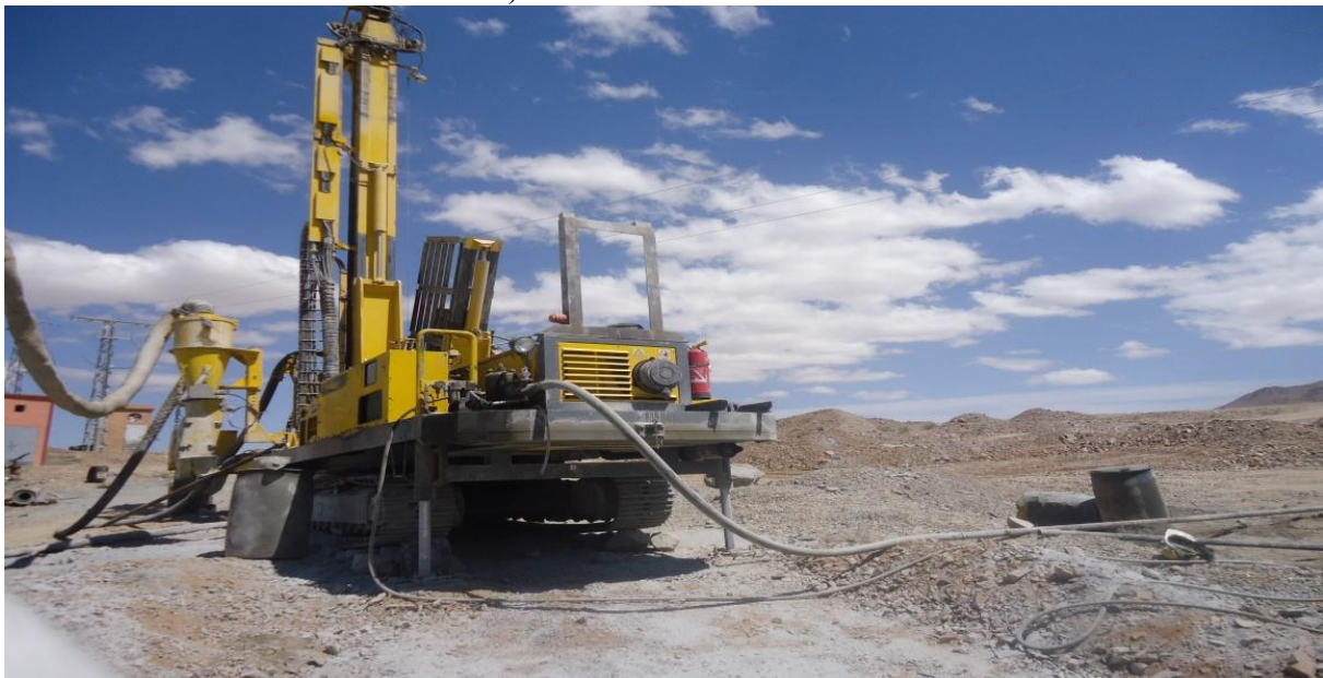
Figure 19 : Machine pour la réalisation des sondages percutants
