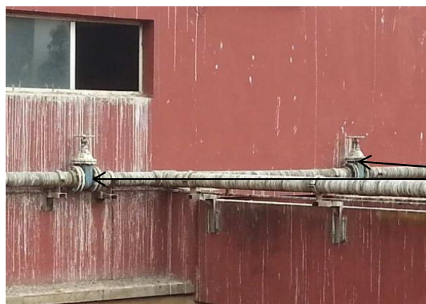
Figure 16: Vannes d'extraction des boues existantes[7]
