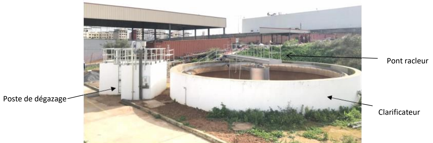
Figure 25: Poste de dégazage et clarificateur
