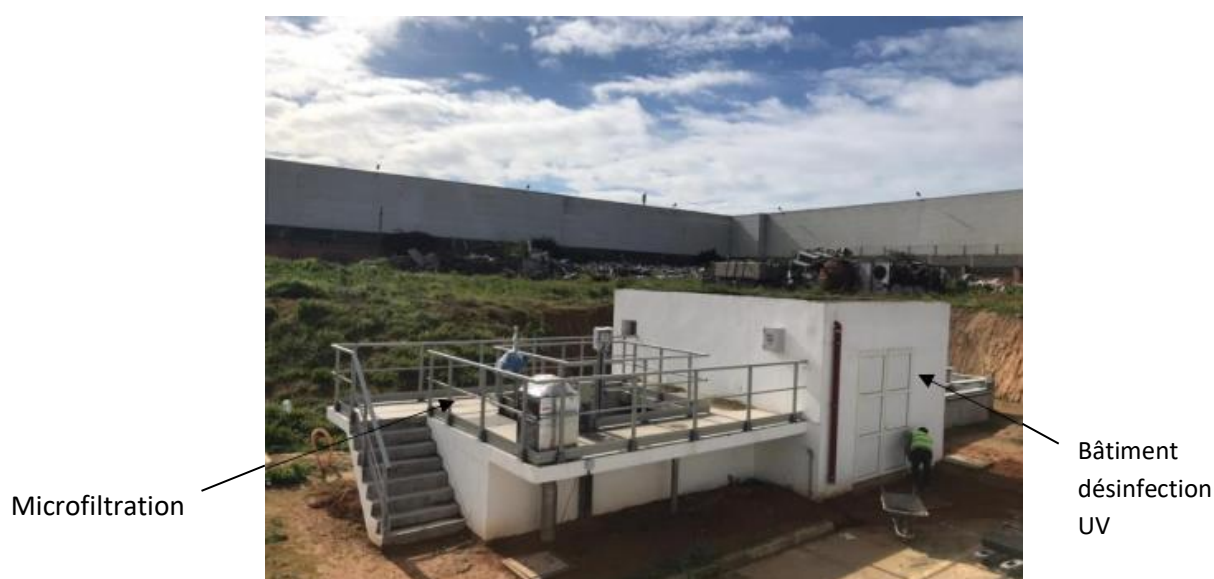
Figure 26: Local traitement tertiaire
