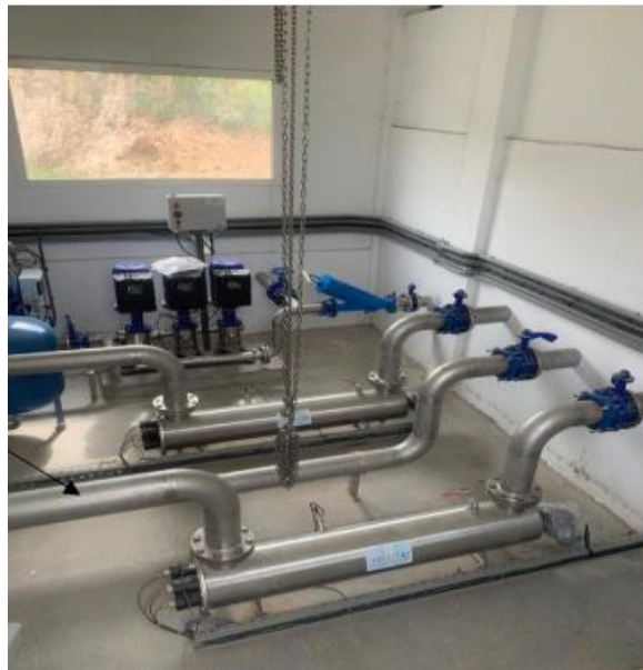
Figure 27: Réacteurs de désinfection par UV
