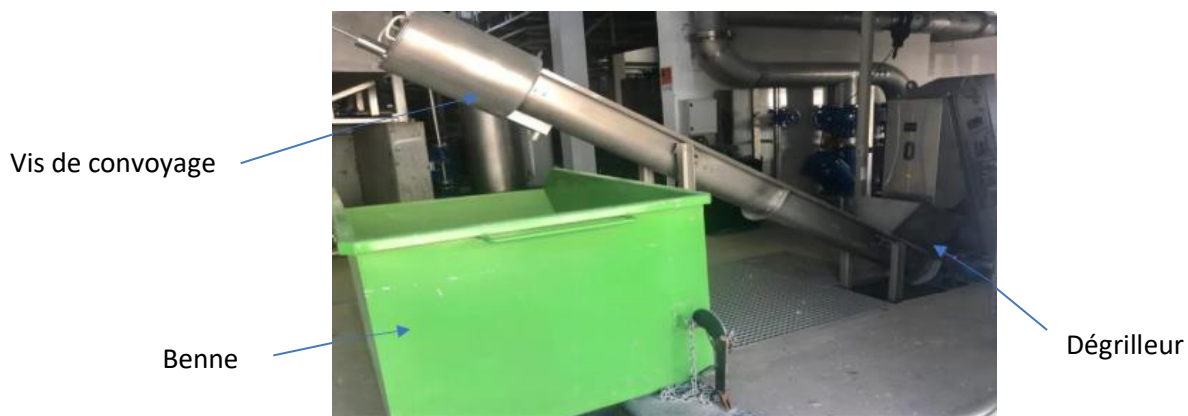
Figure 19: Dégrilleur fin
