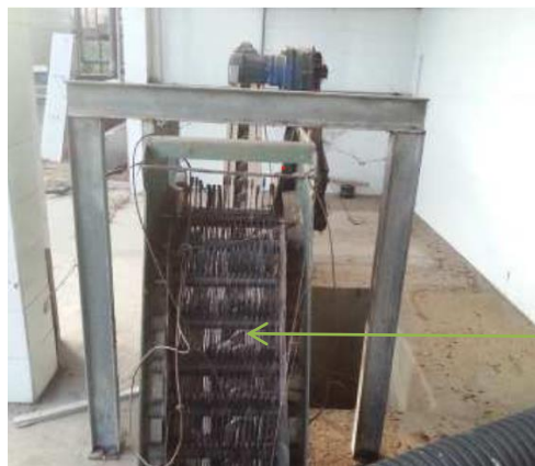
Figure 5: Degrilleur de l'ancienne STEP des abattoirs [7]
