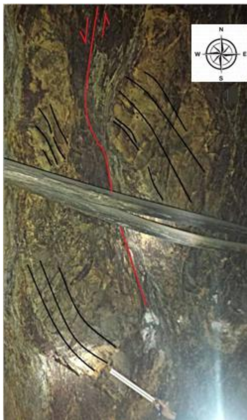
Figure 19 : (A) photo de la stratification décalée par un jeu de faille (Photo prise au fond dans le niveau 400 de l'ExWD)
