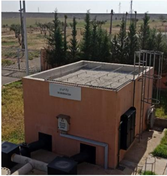
Figure 26 : Désodorisation de prétraitement
