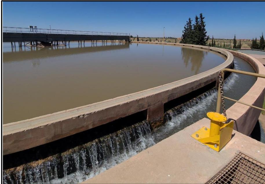
*Figure 10 : Aspect du débouilleur circulaire de la station Rocade (26 April 2024)*
