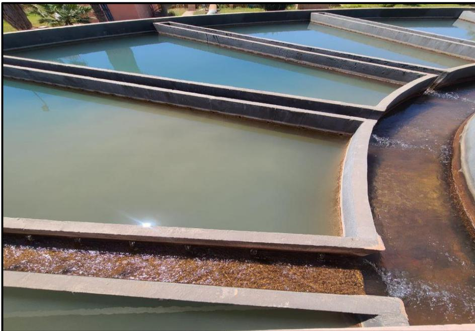
*Figure 14 : Décanteur à recirculation de boues (26 April 2024)*
