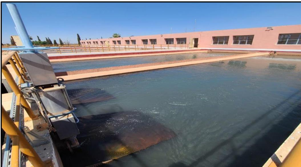
*Figure 15 : Processus de filtration par le filtre à sable (26 April 2024)*
