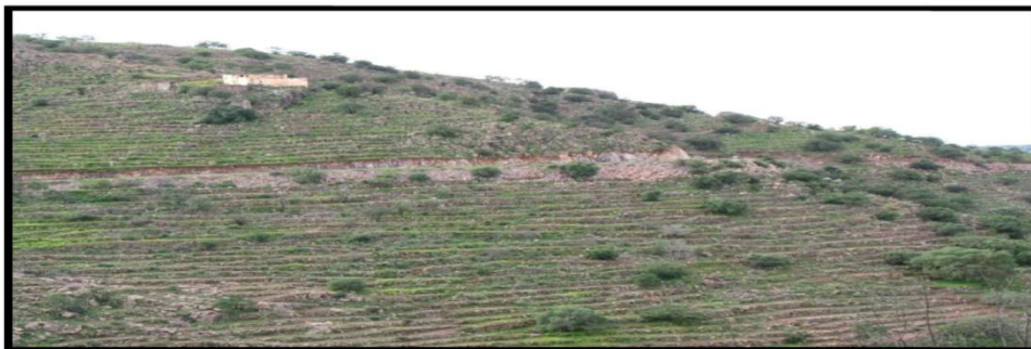
Figure 11 : Construction des terrasses
