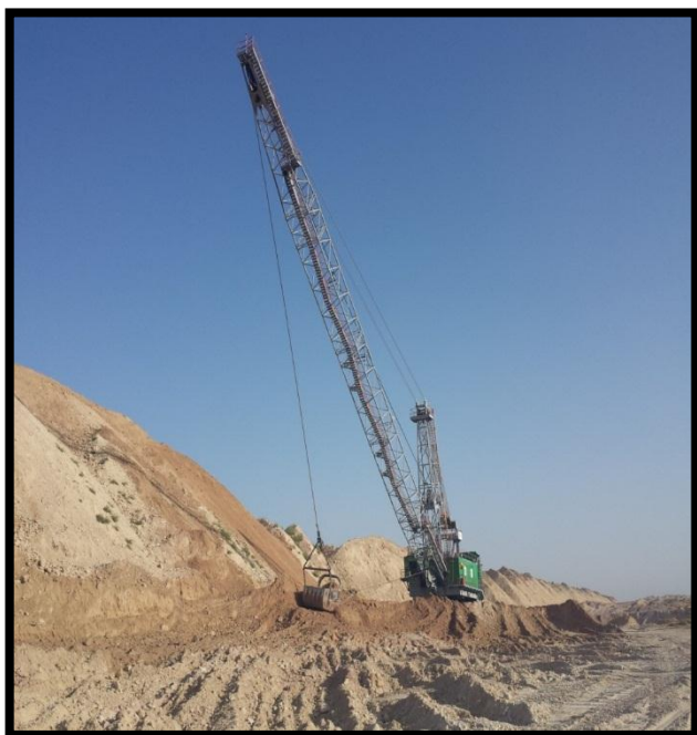
Décapage par casement.
