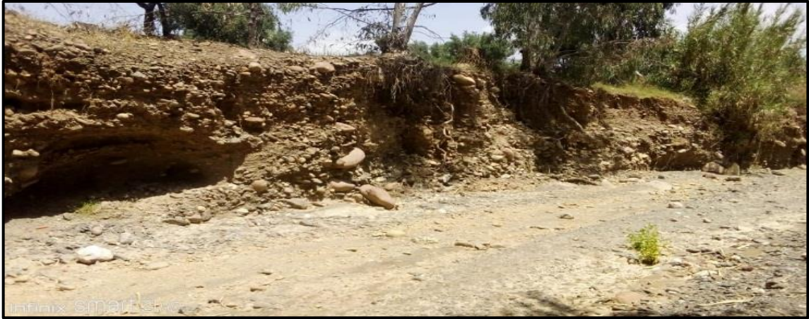
Figure 31 : berge droite du tronçon intérieur de l'oued
