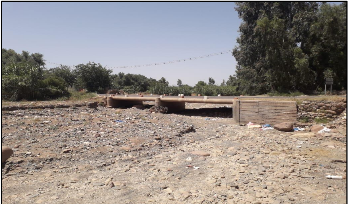
Figure 18 : pont sur la partie amont de la zone étudiée
