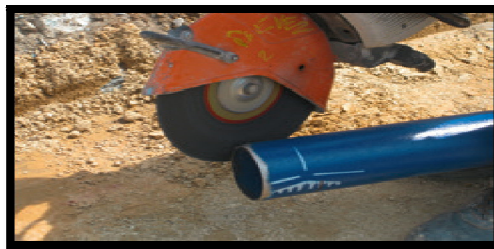
Photo5 : Coupure et alésage de conduite
