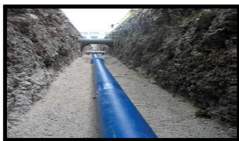
Photo 7: lit de pose du conduit
