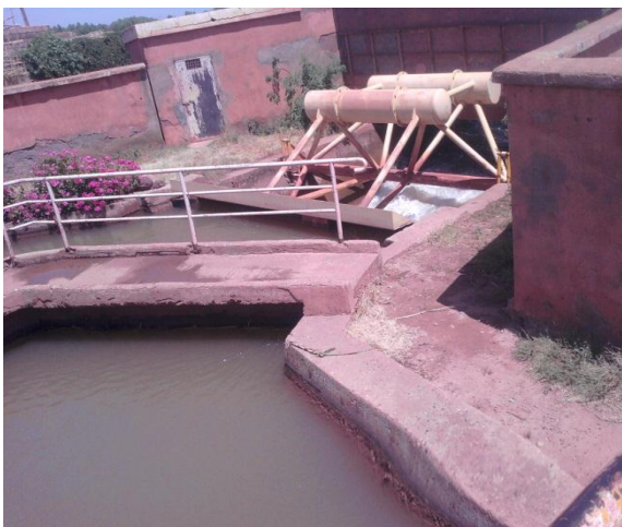
Vanne AMIL du canal Est.
