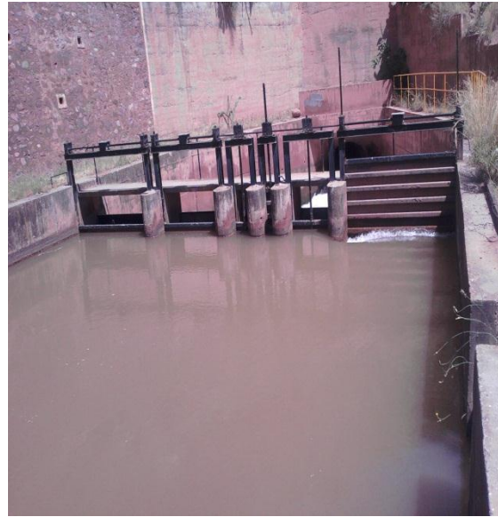
Les modules à masque de l'ouvrage Agadir Bou Achiba
