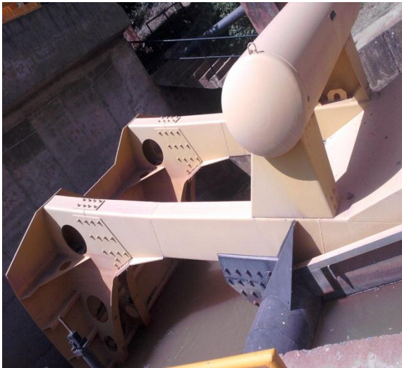
Vanne AMIL de l'ouvrage.
