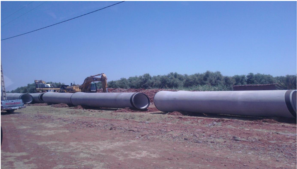
Commencement du travail de reconversion dans le secteur d'Oulad Gaïd.
