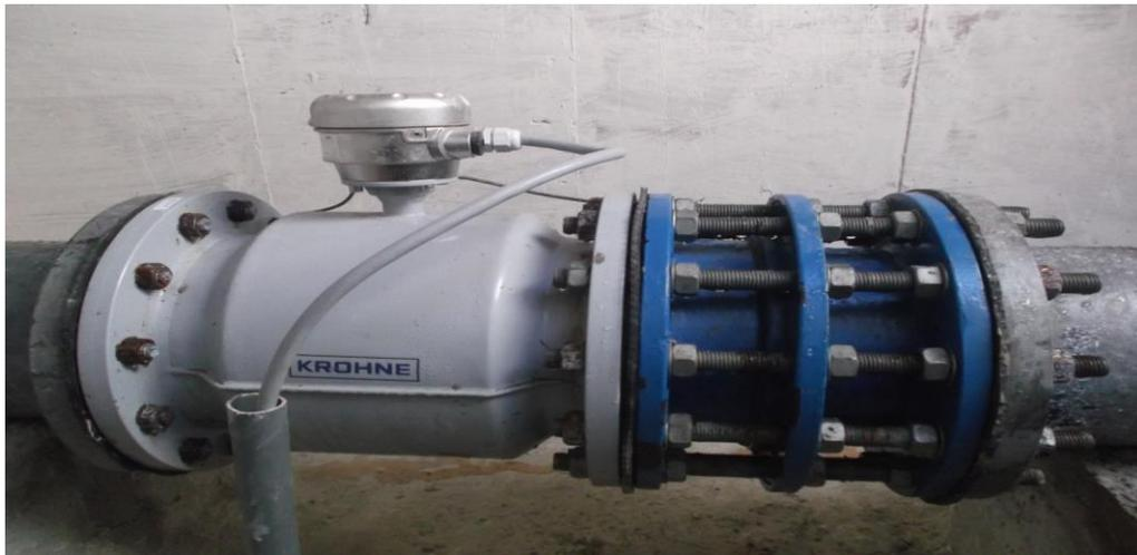
**Figure18 : L'appareil de débitmètre**
