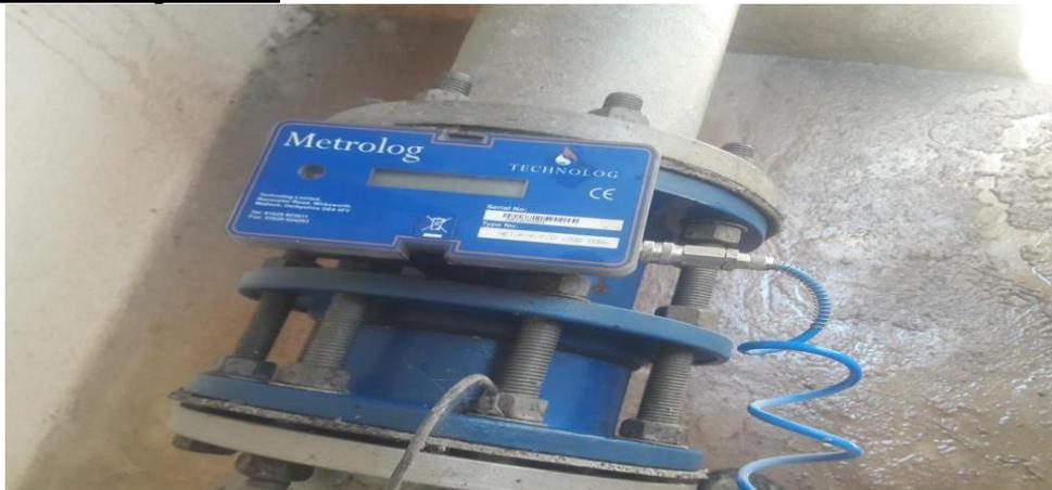
**Figure 21 : appareil de mesure de pression (metrolog)**
