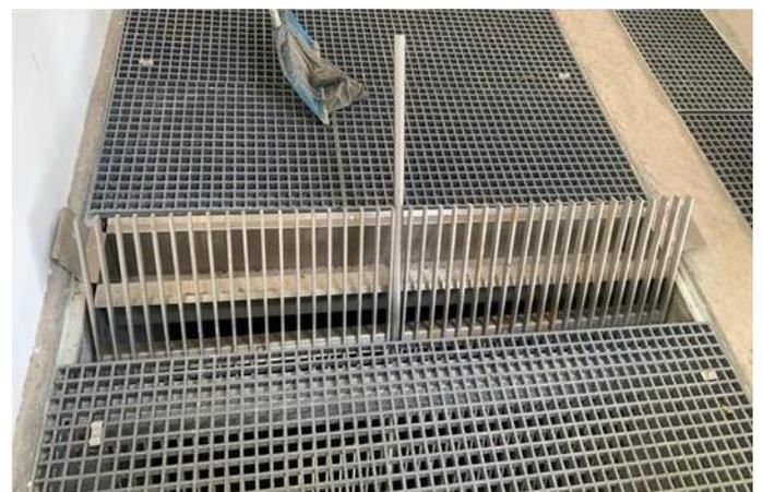
Figure 10:Les deux dégrilleurs fins.
