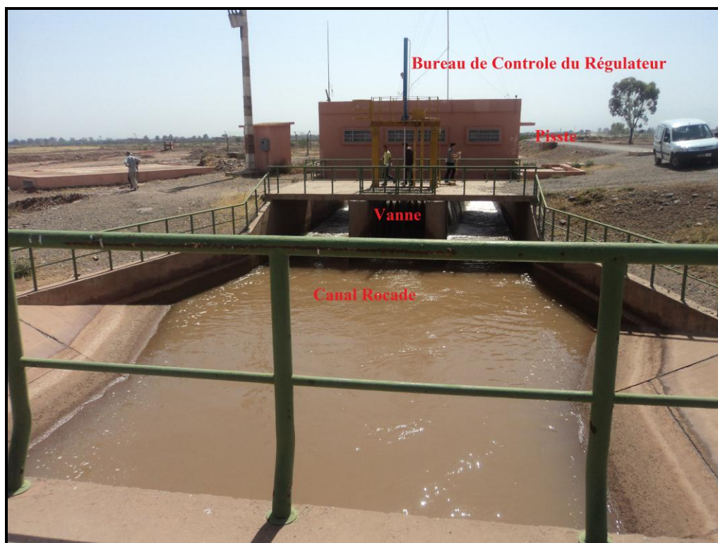
Figure 14 : Exemple de régulateur de commande des vannes du canal de Rocate
