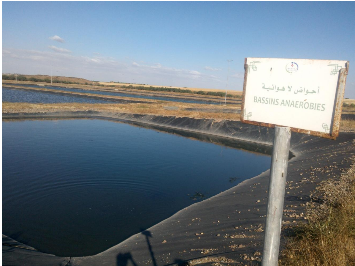
Photo 6 : Photo d'un bassin anaérobie dans la station d'épuration de Ouled Frej
