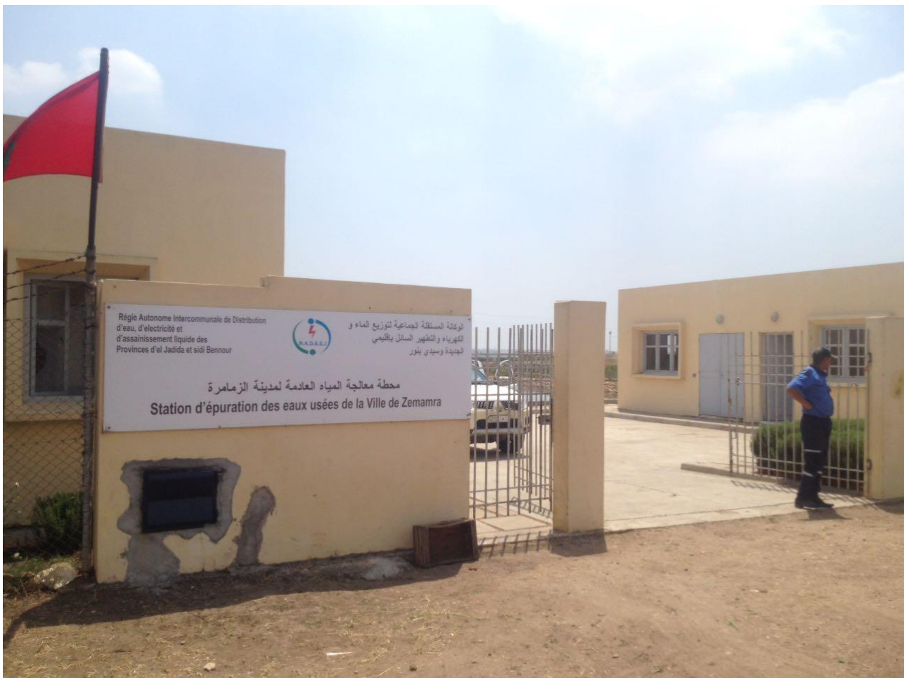
Photo 7 : Photo représentant la station d'épuration des eaux usées de Zemamra
