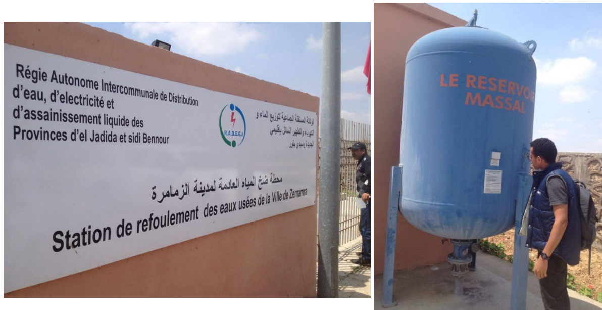
Photo 1 : Photo représentant une station de pompage à Zemamra
