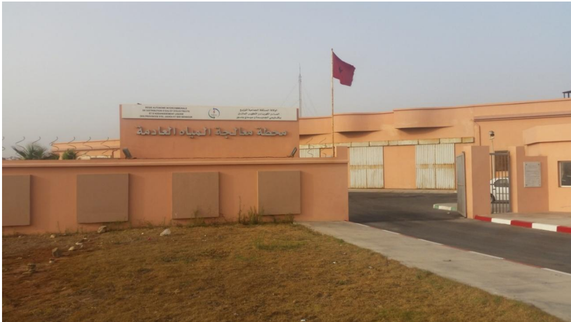
Photo 5 : Photo de la station de prétraitement des eaux usées d'El Jadida
