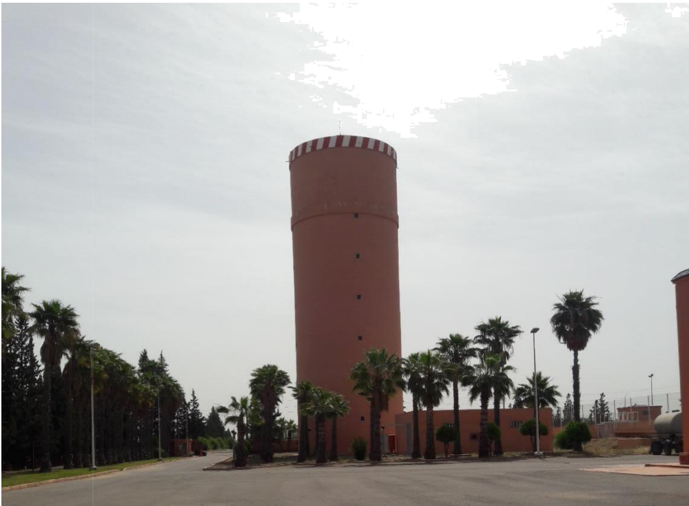
Figure 12 : Château du très haut service (réservoir étudié)
