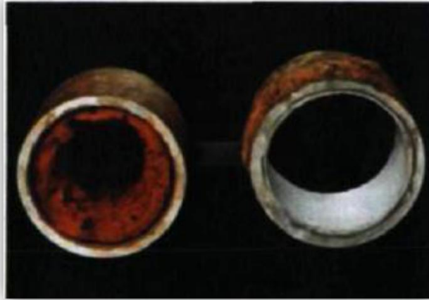
Figure 8: Différence de diamètre entre une conduite âgée et une réhabilitée
