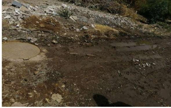
**Photo 5 :** Puits perdu inondé réalisé par (RADEEMA) au Douar Moulay Azzouz 1.
