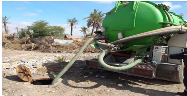
**Photo 6 :** Le processus de vidange de puits perdu lie à la fosse septique de douar Moulay Azouze 1 par les techniciens d'hygiène de RADEEMA.
