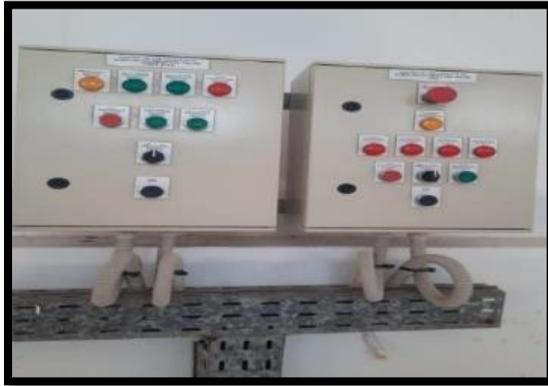
Figure 32 : Régulateur vannes et pompe
