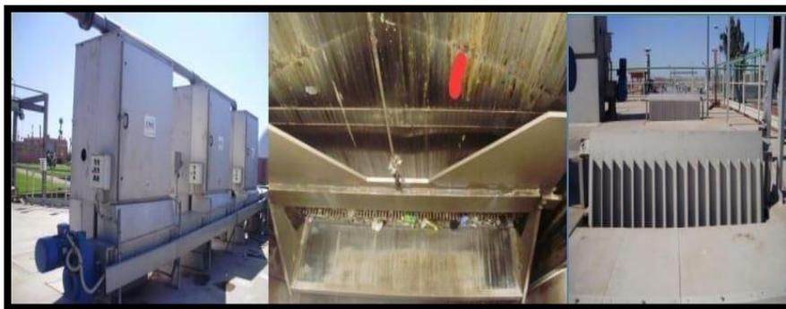
**Figure 14 :** Grille automatique (à gauche) ; grille manuelle (à droite)
