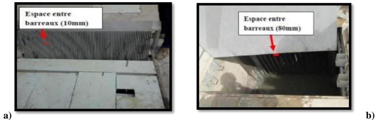
**Figure 13 :** a) dégrillage ; b) dégrillage grossier
