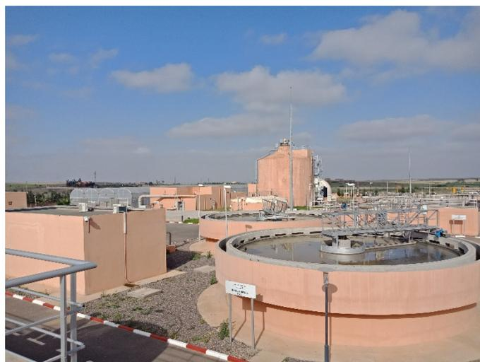
Photo 6 : Les deux décanteurs
