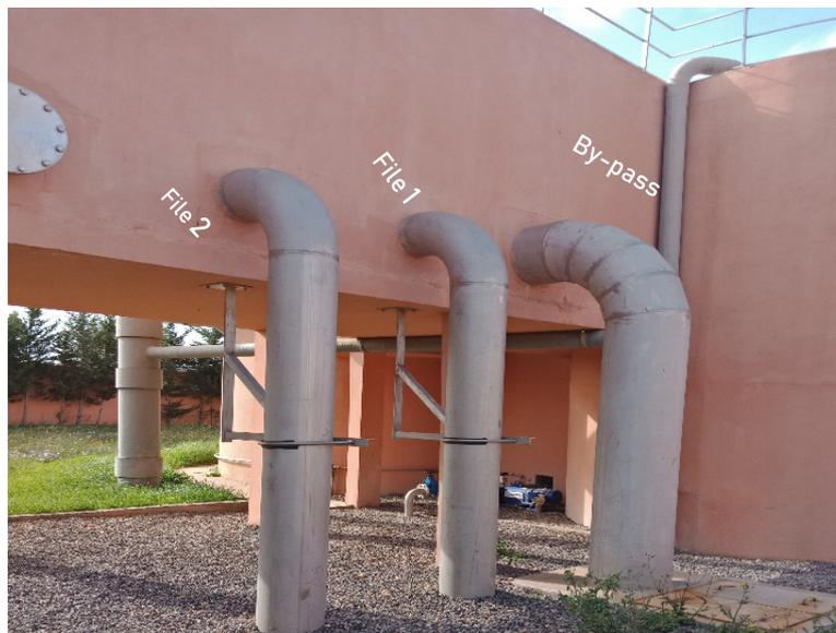
Photo 7 : Les deux files de décanteur
