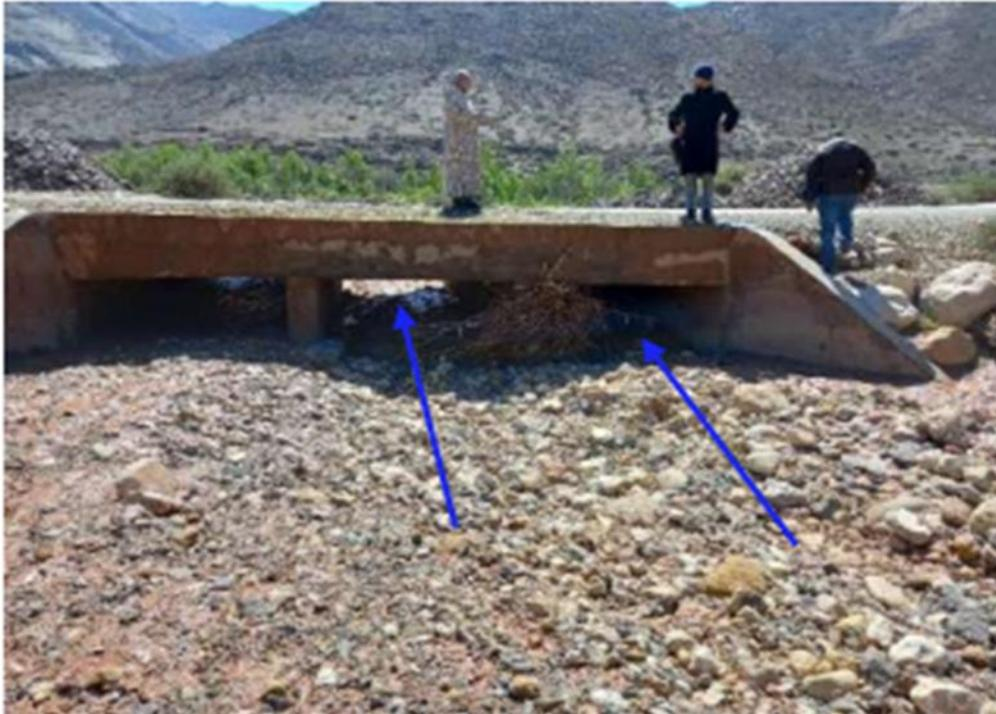
Image E : ouvrage de franchissement de la RP2032 : Dalot triple de 2.00×2.00m envasé
