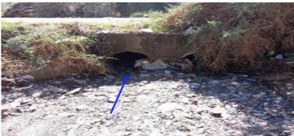
Image I : ouvrage de franchissement de la RP2032 : deux buses envasées
