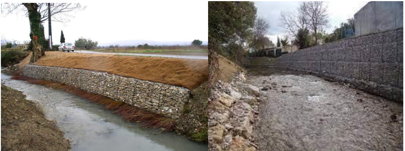
Figure 17: des exemples des murs de soutènement contre les inondations.
