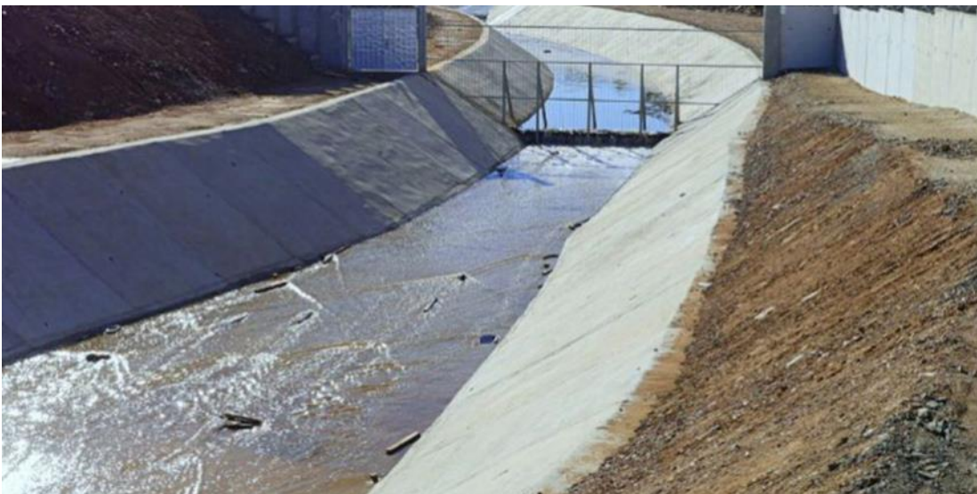
Figure 19: exemple de canal trapézoïdal en béton.
