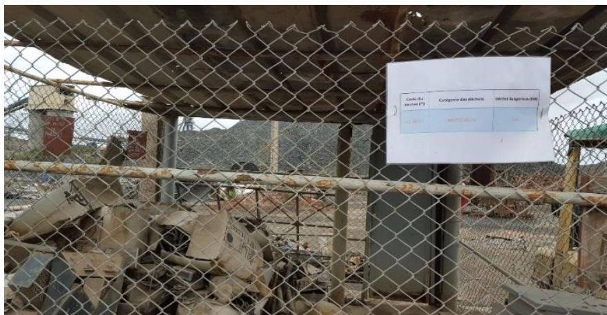
Figure 14 : Zone de stockage des batteries usées
