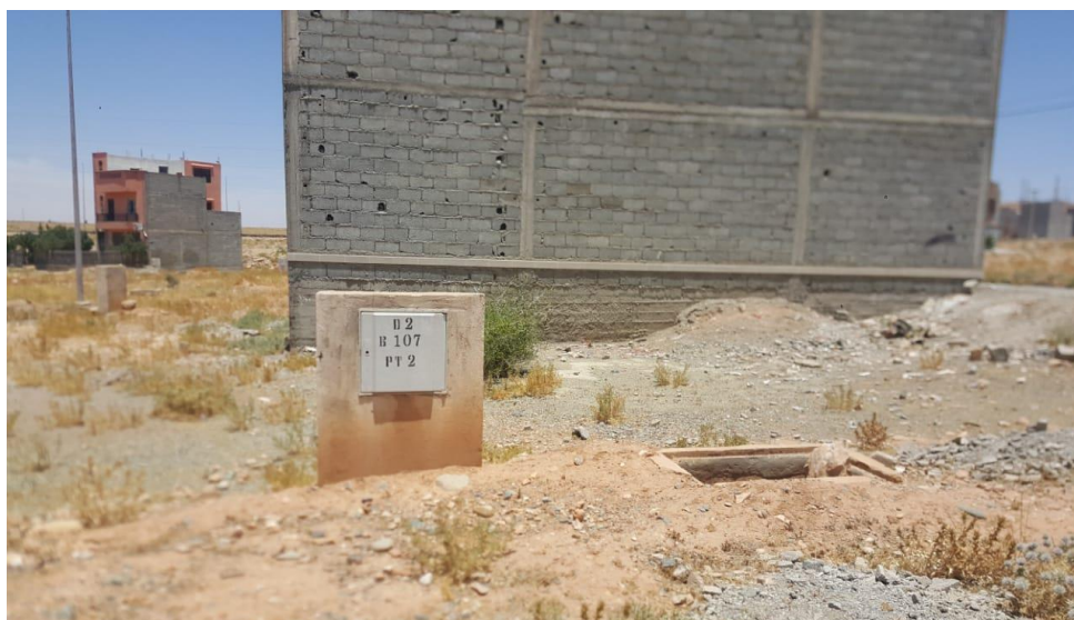
Photo 15 : Problème de dimensionnement d'une boite de branchement double
