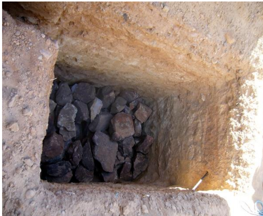
Photo 11 : puit perdu traditionnel rectangulaire avec Caillaux d'infiltration
