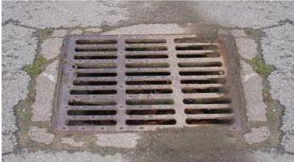
Photo10 : Bouche d'égout a grille (vue dessus).
