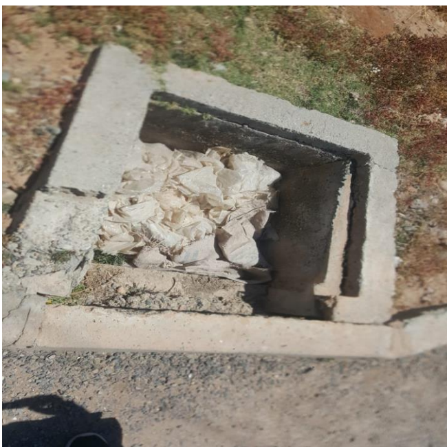
photo 13 : Boite de branchement colmatée
