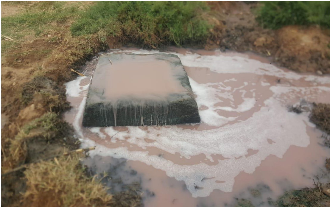
Photo 22 : dispositif de rejet des eaux épurées d'après la STEP
