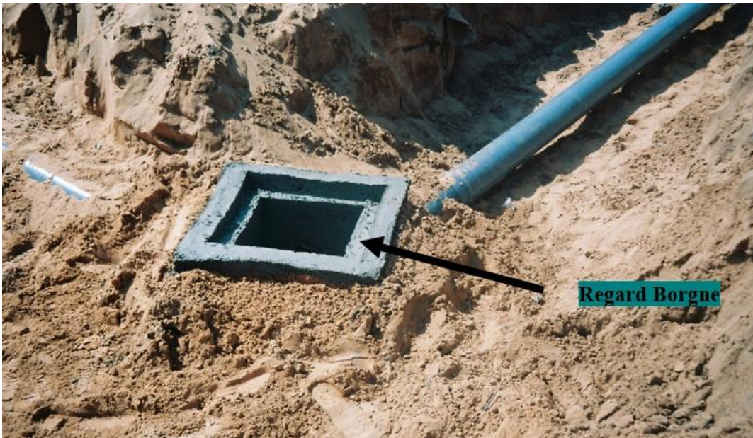
Photo 8 : travaux d'implantation d'un regard borgne.
