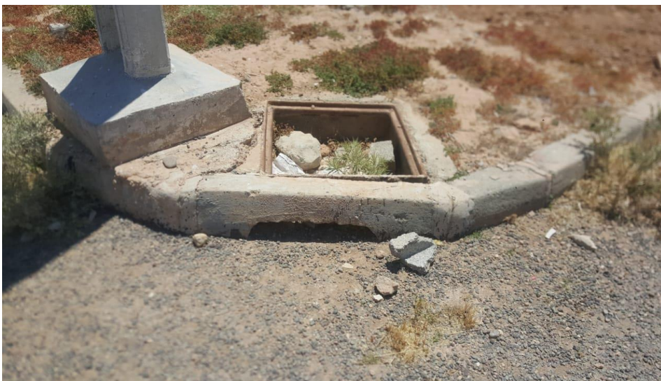
Photo 20 : absence du tampon et colmatage d'une bouche d'égout
