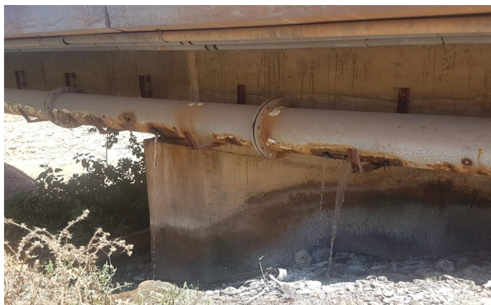
Photo 12 : conduite en acier galvanisé totalement dégradé.
