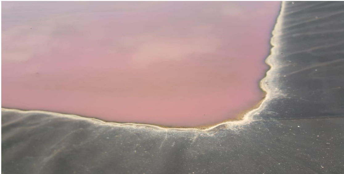
Photo 21 ; Coloration rougeâtre des eaux au niveau du bassin facultatif
