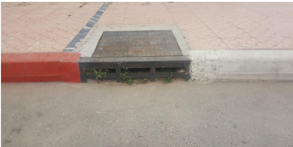
Photo 9 : bouche d'égout à avaloir (ville de chichaoua) .
