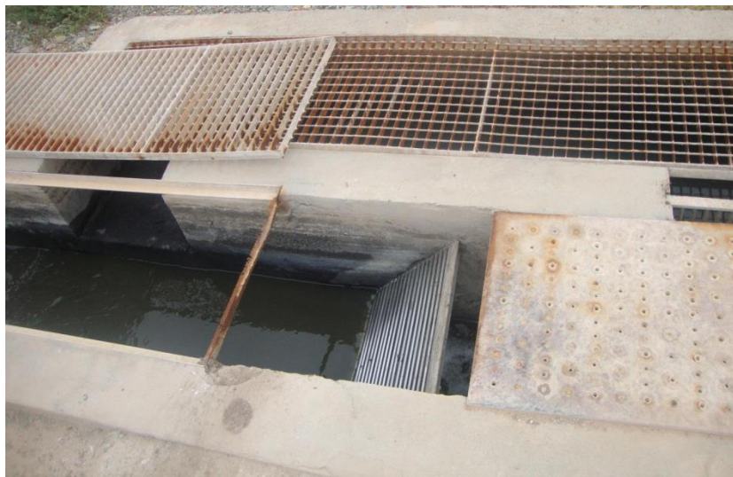
Photo 23 : Type de dégrilleur utilisé dans la STEP de Chichaoua.
