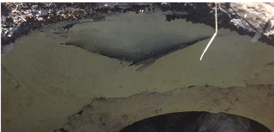
Photo 18 : Concrétion calcaire développée sur les parois intérieures d'un RV
