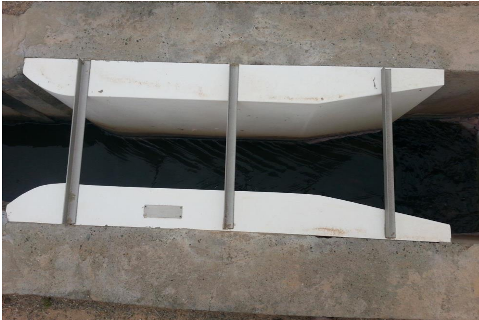
Photo 24 : dessableur utilisé dans la STEP de Chichaoua.
