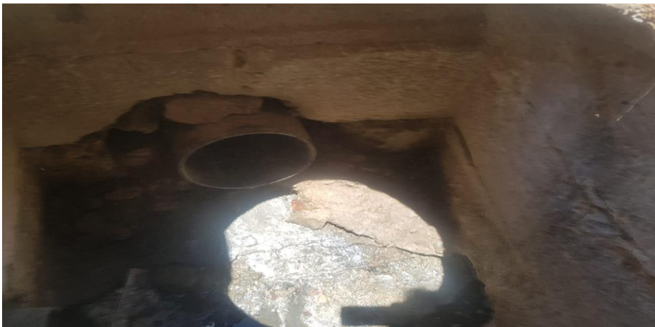
Photo 17 : problème d'étanchéité d'un RV
