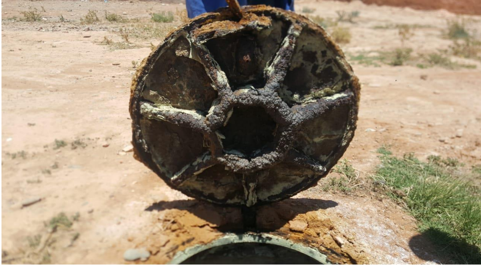
Photo 16 : Tampon dégradé d'un RV
