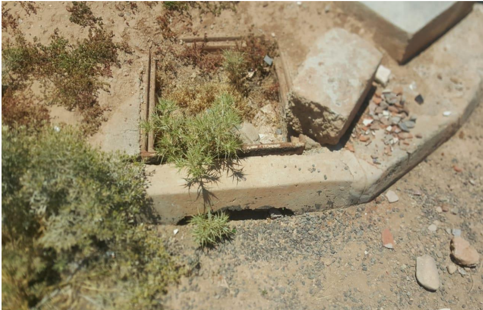
photo 19 : Bouche d'égout colmaté avec développement de la végétation
