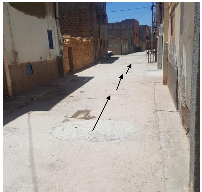
photo 14 : boite de branchement en séries
