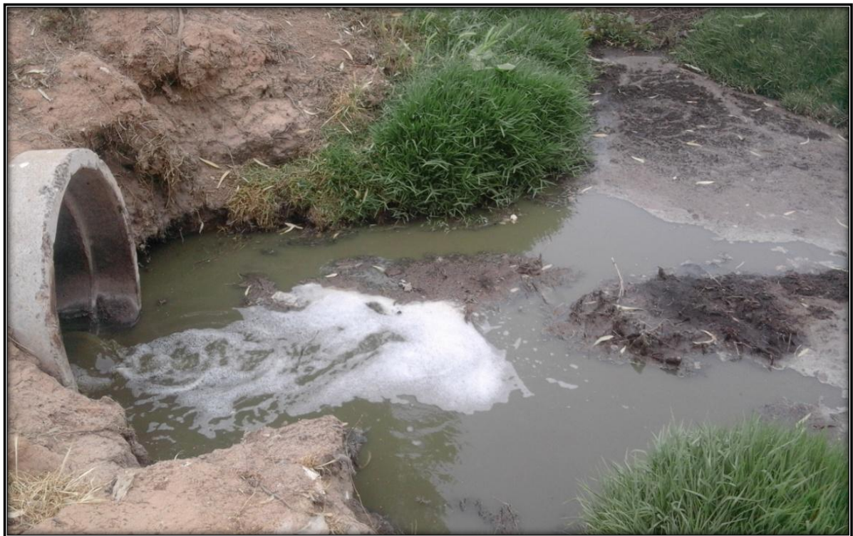
Figure 9: exemple Le point de rejet des eaux usées dans l' Oued Bou Zaahran.
