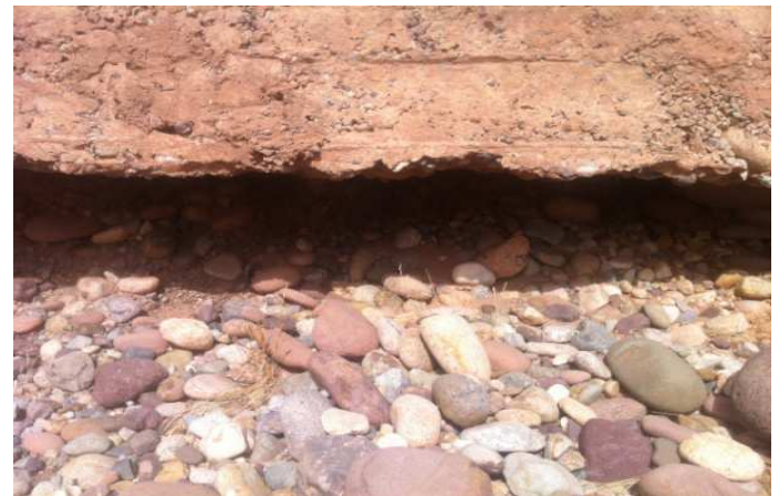
Photos 9 et 10 : photos Montrons le problème des affouillements au dessous Des seuils
