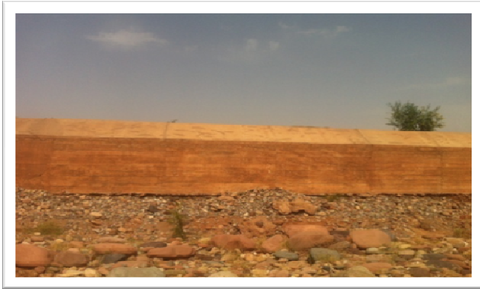
Photos 7 et 8 : Photos montrant l'un des seuils réalisé dans le lit de l'oued Zat en 2014
