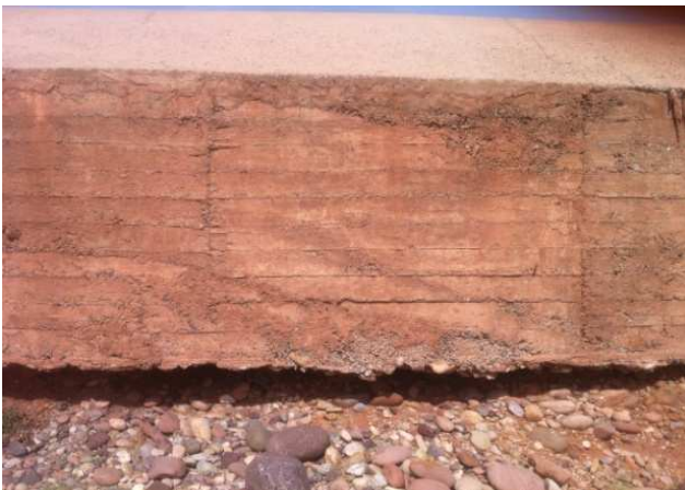
Photos 9 et 10 : photos Montrons le problème des affouillements au dessous Des seuils
