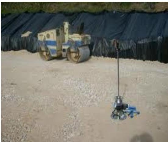
Photo11:Compactage d'un remblai
