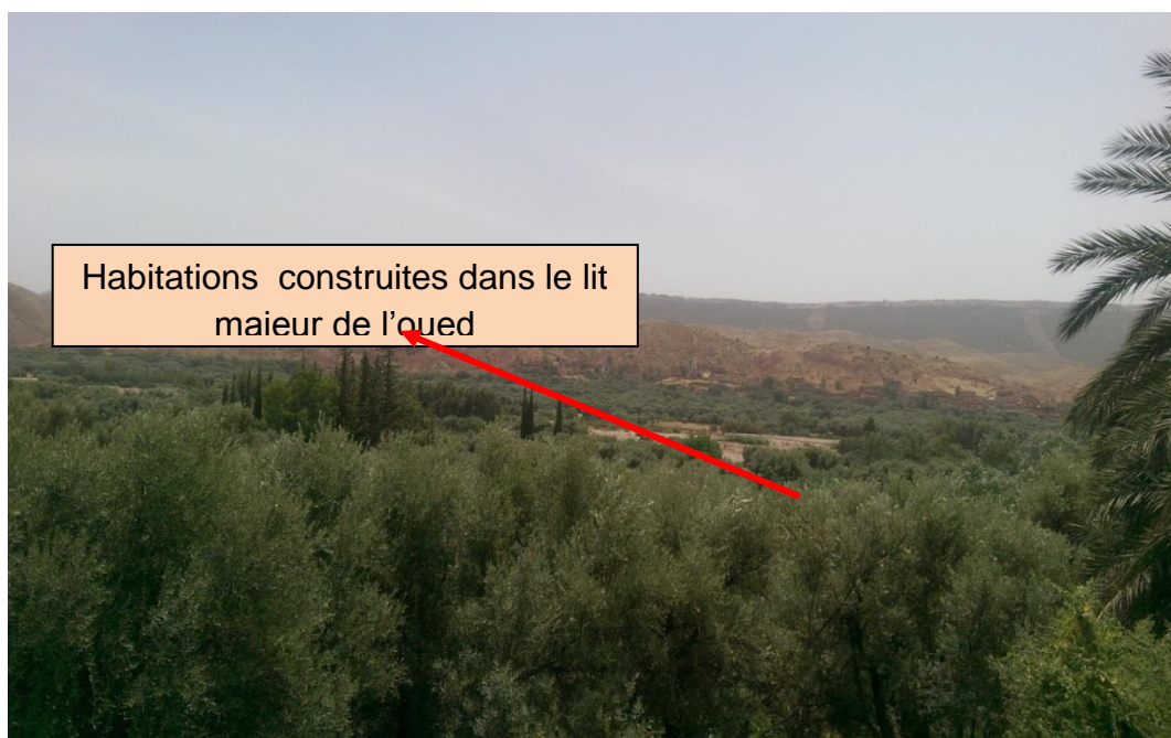
Figure 29: Habitation construites dans le lit de l'oued
