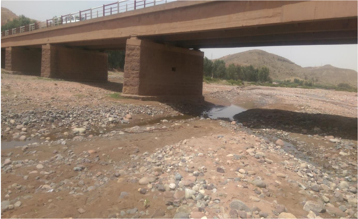
Figure 26: Le pont sur la Route
