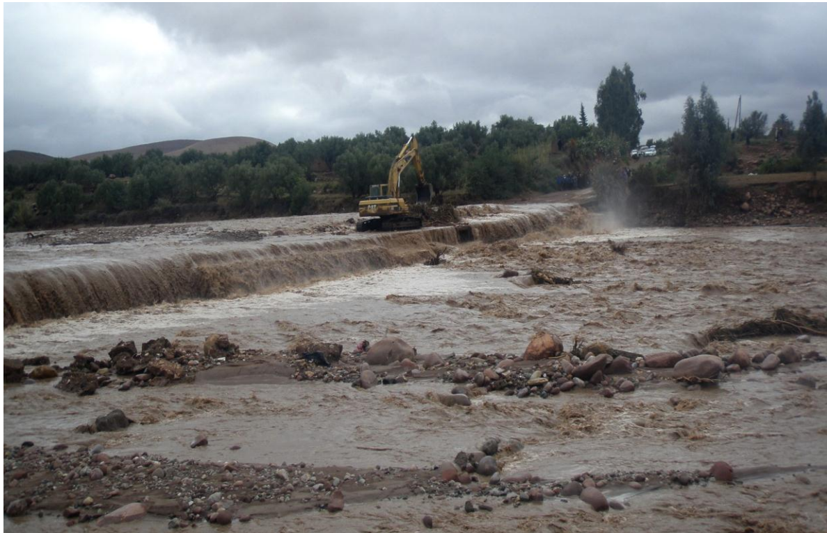
Photo1 ;2 : dégats de la crue du 28 novembre 2014
