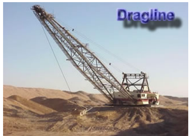
Photo 3: opération de Décapage
