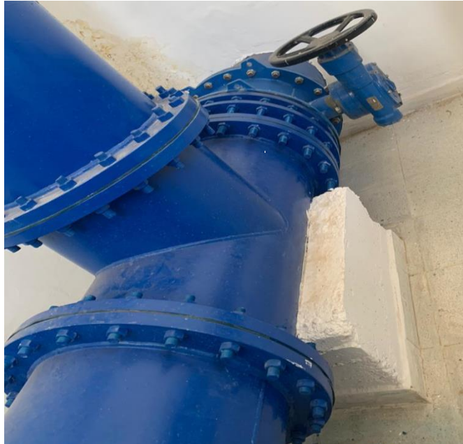
Figure 9: Vidange au réservoir Bir Ramram
