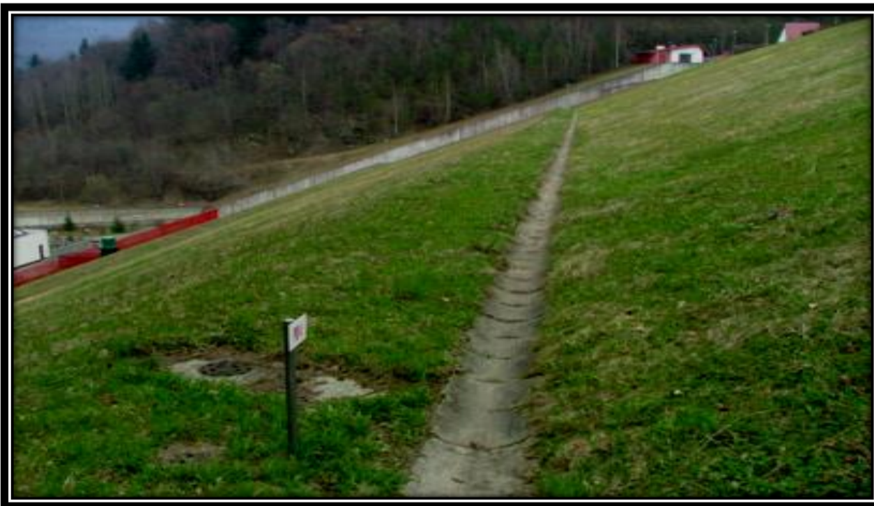
Figure 40: Exemple de la protection du talus aval par l'enherbement (Wikibardig)
