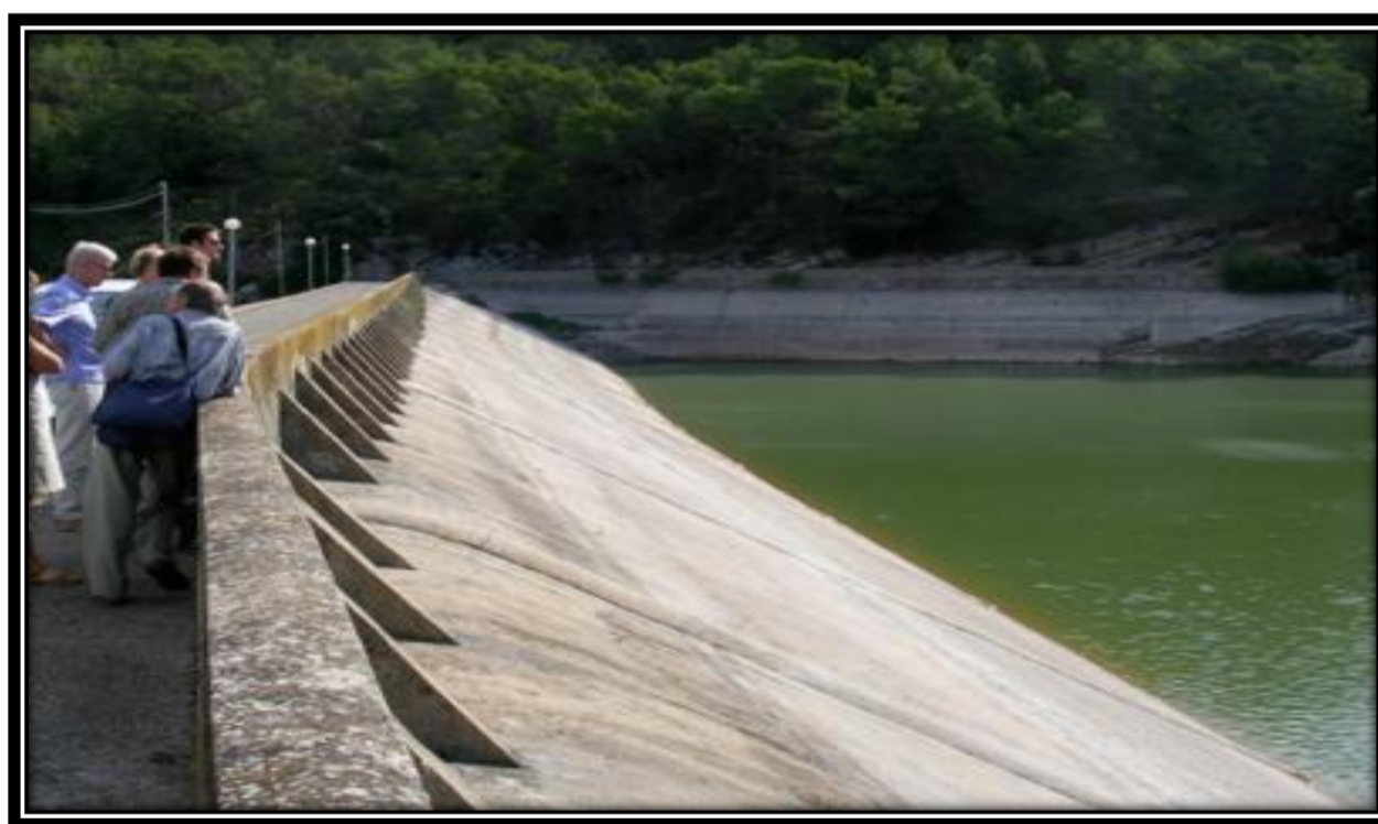
Figure 38: Exemple de protection du talus amont par dalles en béton (Wikibardig)
