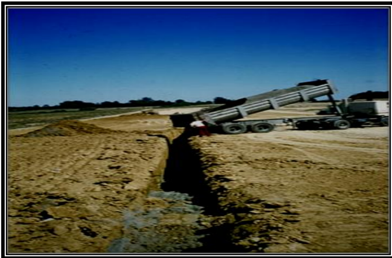
Figure 35: Réalisation d'un drain (Wikibardig)
