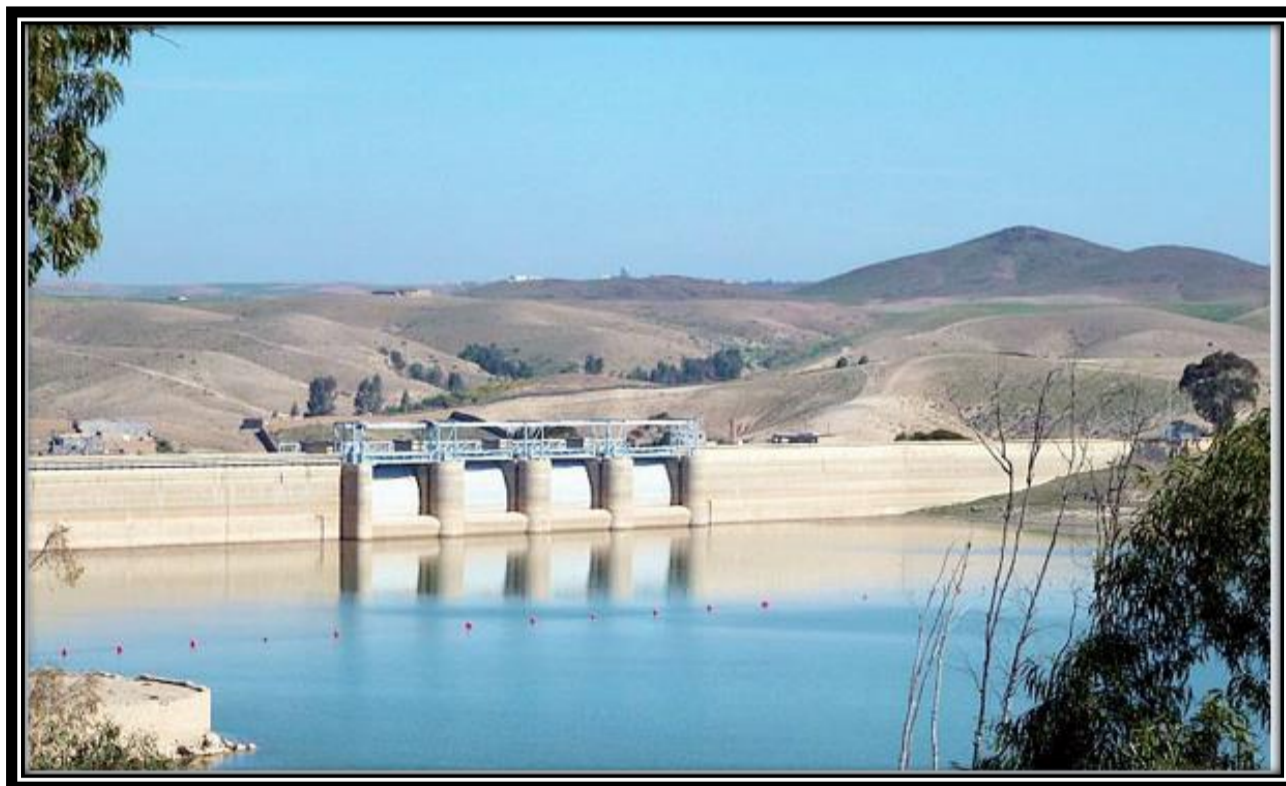
Figure 18: Barrage poids en béton (ANTON ET HENRI, 2011)
