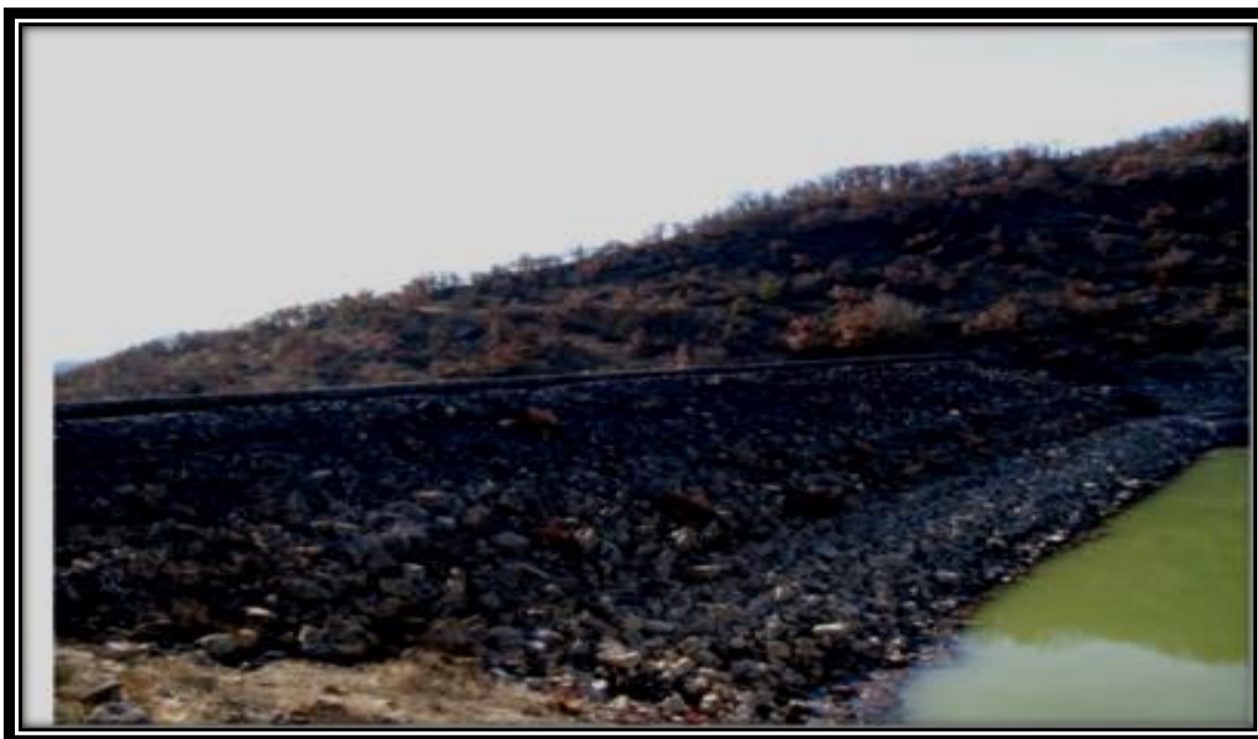
Figure 37: Exemple de talus amont protégé par RipRap (Wikibardig)
