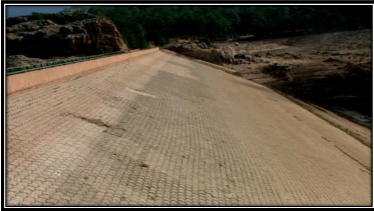
Figure 39: Exemple de protection du talus amont par pavés autobloquants (Wikibardig)
