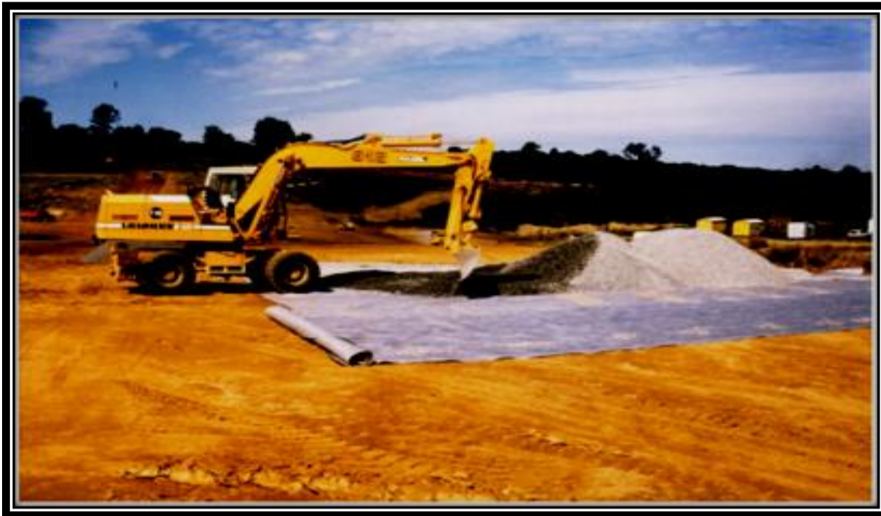
Figure 36: Réalisation d'un filtre (Wikibardig)
