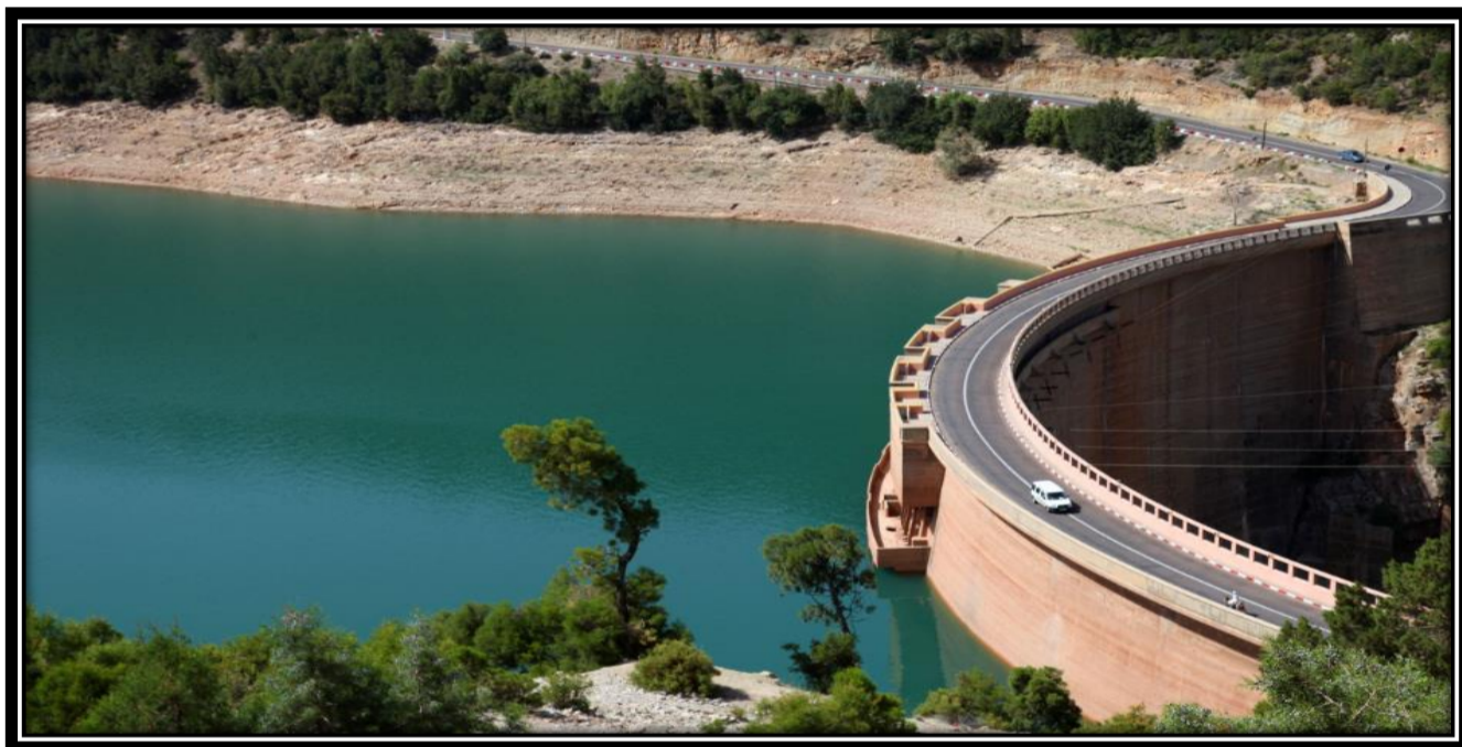
Figure 21: Exemple de barrage voûte (barrage bin El Ouidane, 1953)
