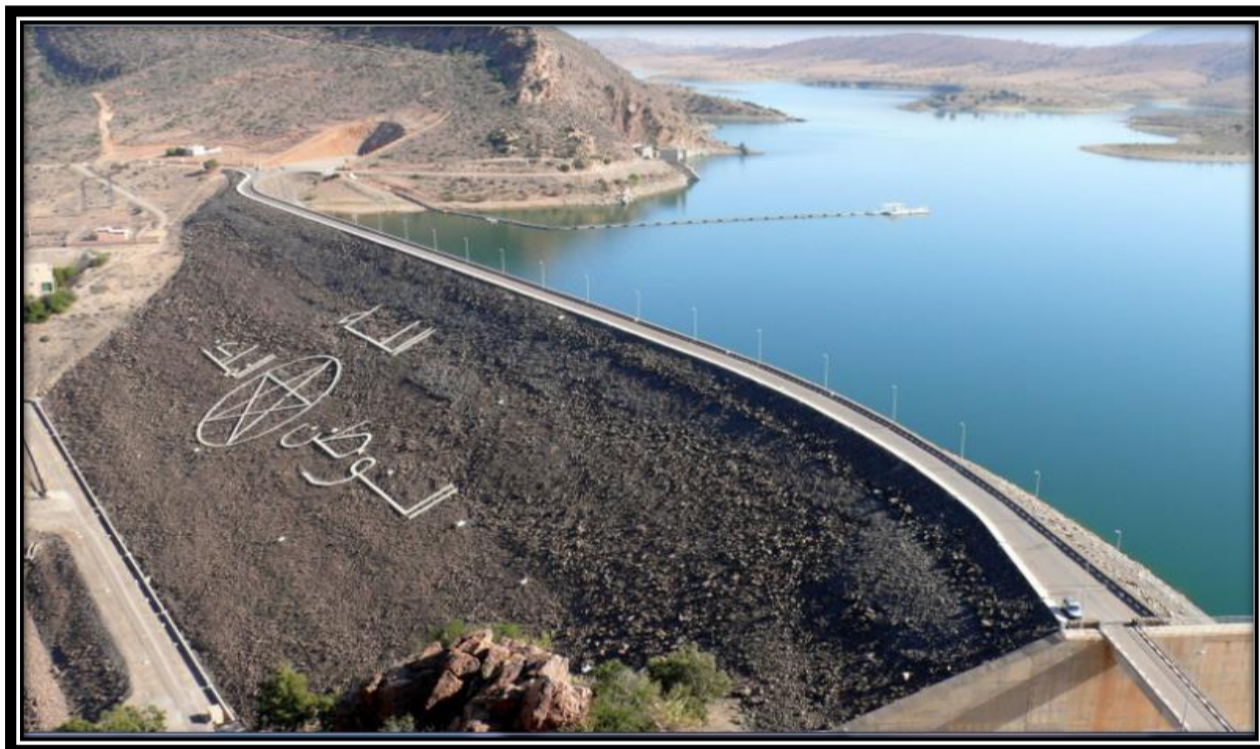
Figure 27: Exemple de barrage en remblai à noyau (Al Makhazine)
