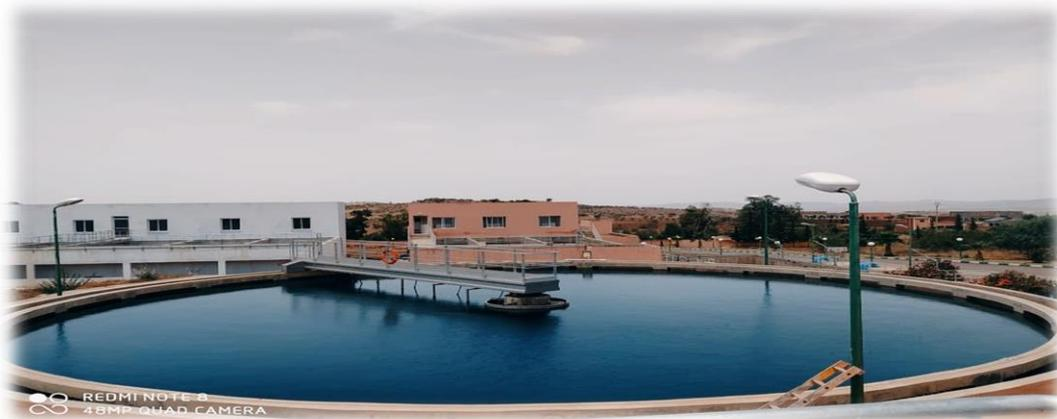
**Figure 15** : décanteur
