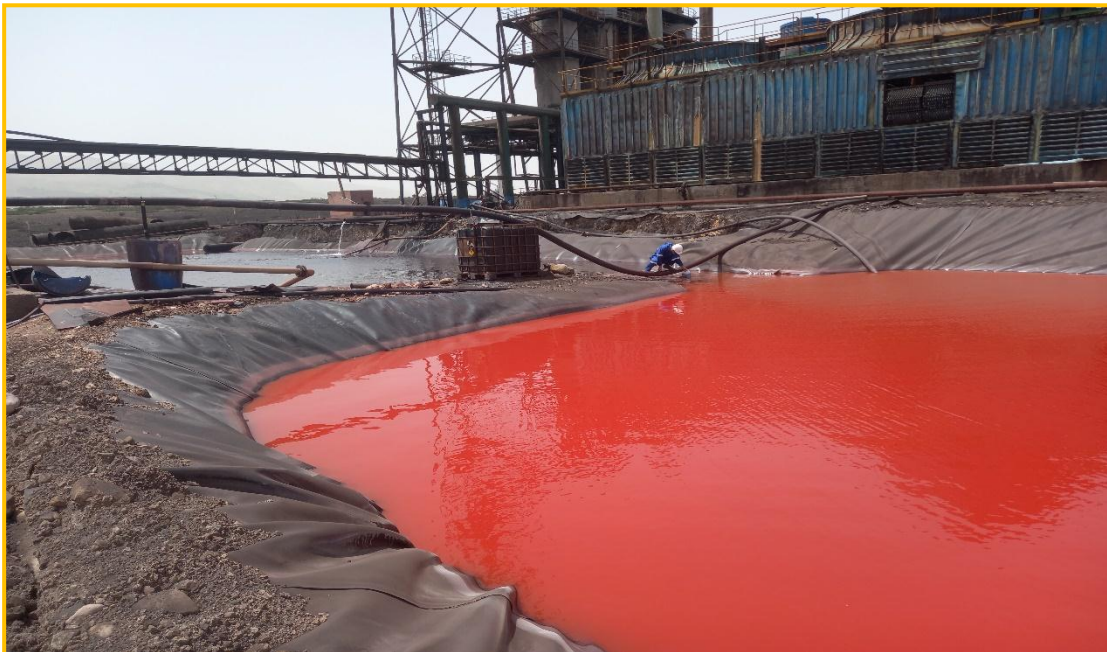
Figure 14 : Photo de la géomembrane des effluents d'usine d'acide
