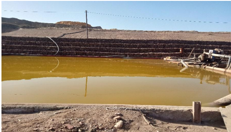
Figure 16 : Photo du bassin ligne 2
