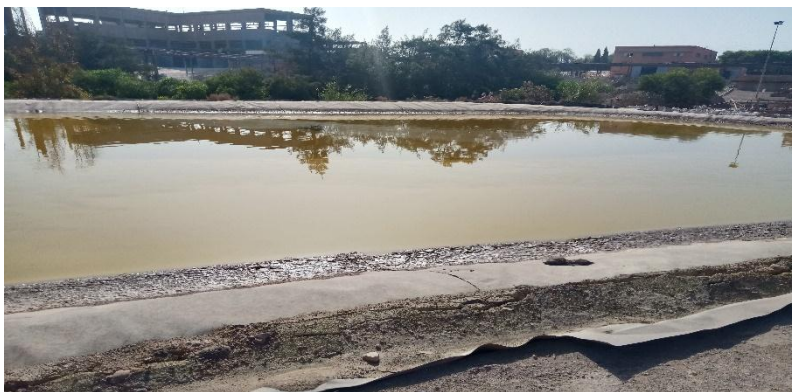
Figure 15 : Photo de la bassin ligne 1
