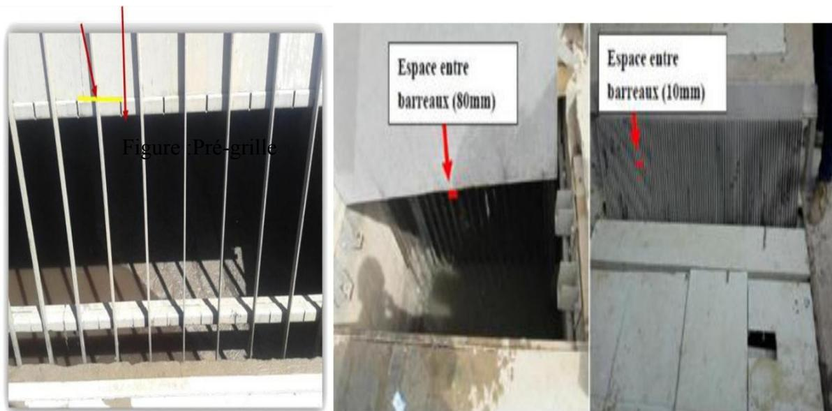
Figure3 : Différents types des dégrilleurs
