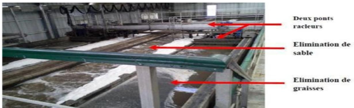
**Figure 5 : Élimination du sable et de la graisse.**
