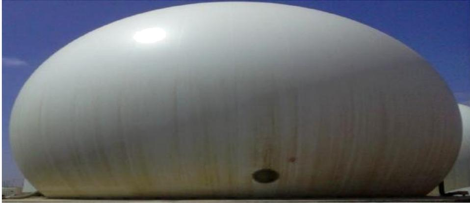
**Figure 19 : Stockeur de gaz de la STEP de Marrakech (gazomètre)**
