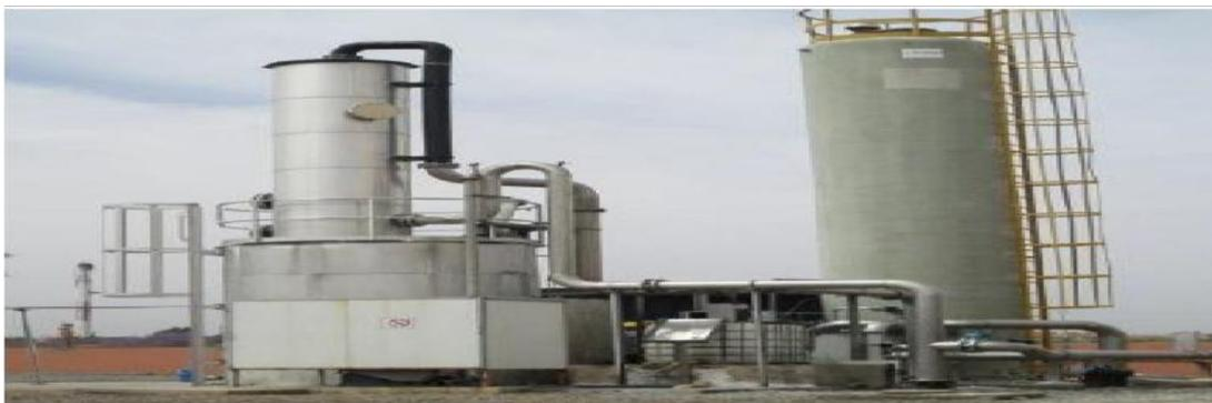
**Figure 17 : Désulfuriseur de la STEP de Marrakech**
