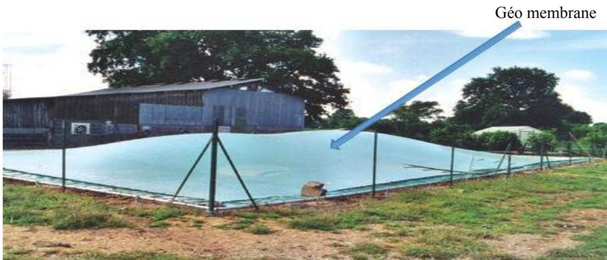
Figure 41 : Photo d'un bassin couvert par un géo membrane (Site web : 3)
