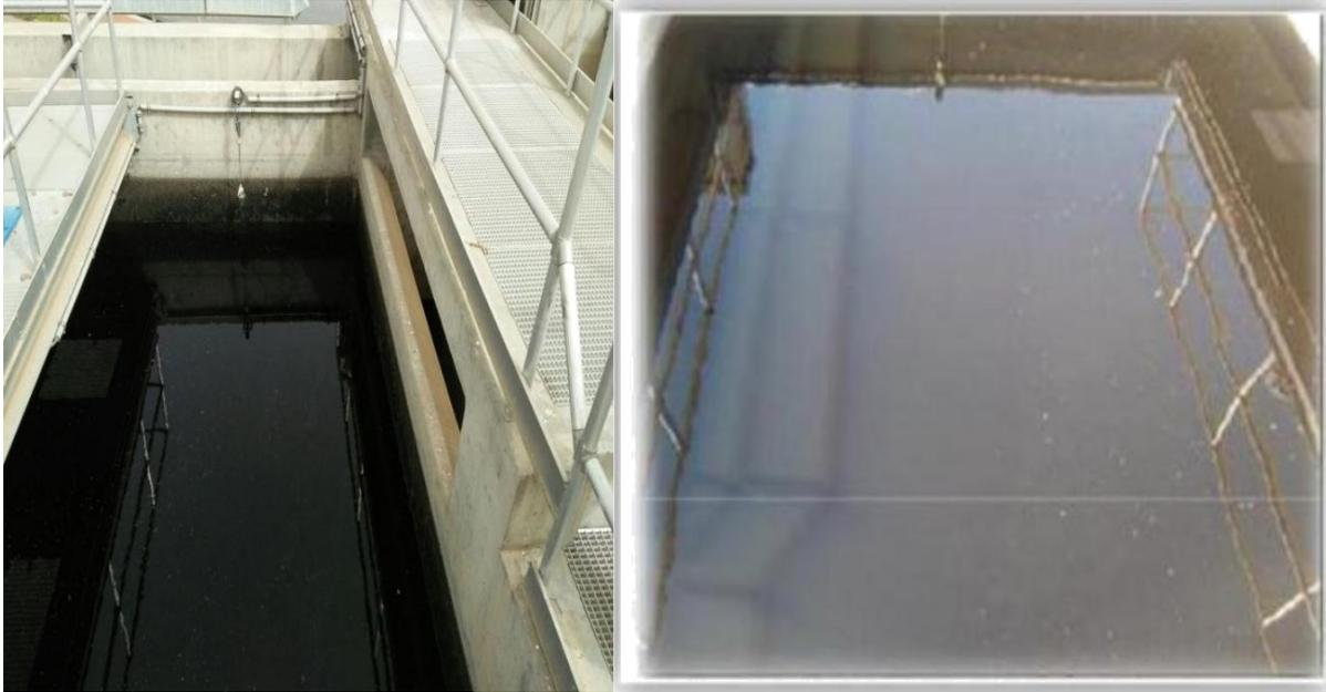
**Figure11 : Coagulation-Floculation**
