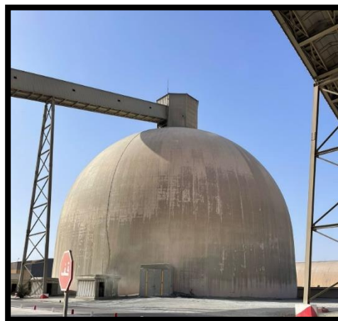
Figure 13 : Dôme de stockage du clinker (documents internes de la-société).
