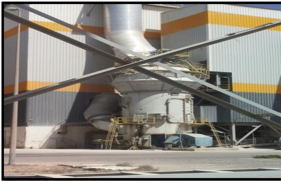
Figure 9 : Broyeur à cru (broyage des matières premières) (documents internes de la-société).
