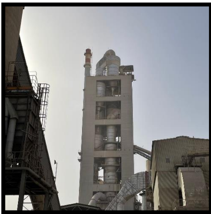
Figure 10 : La tour à 5 cyclones (documents internes de la-société).
