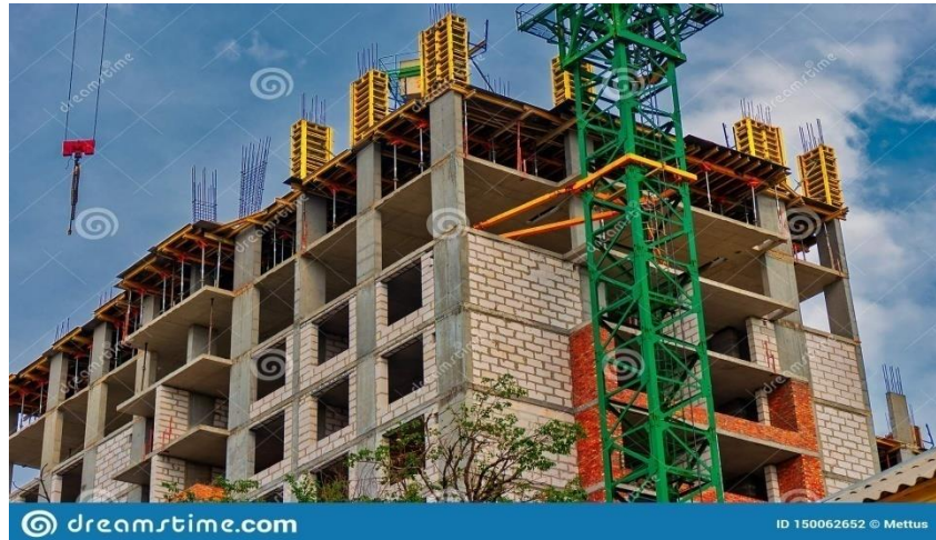
Figure 4 : Construction d'immeuble, chantier avec les murs en béton
