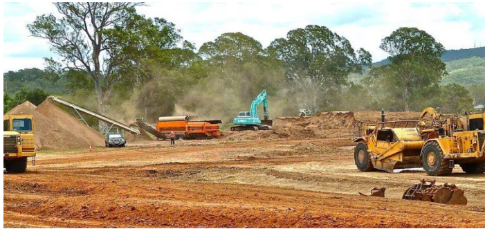
Figure 12 : Enlève de forets pour préparation d'une route
