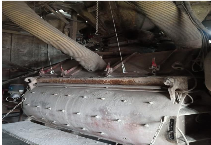
Figure 35 : tube du ciment inséré dans le malaxeur
