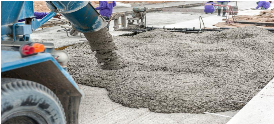
Figure 2 : Le béton prêt à l'emploi (BPE)
