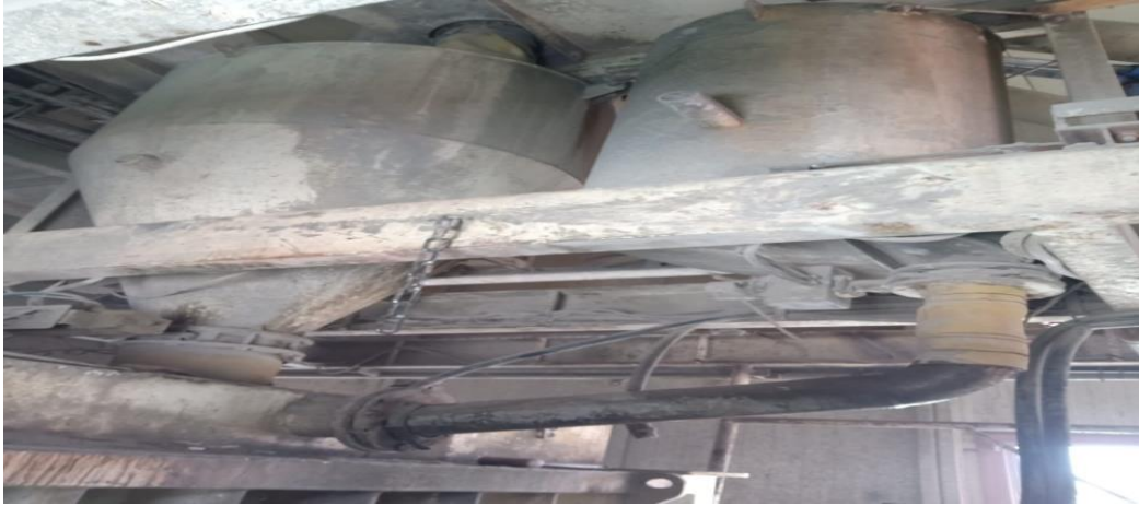
Figure 30 : citerne du ciment
