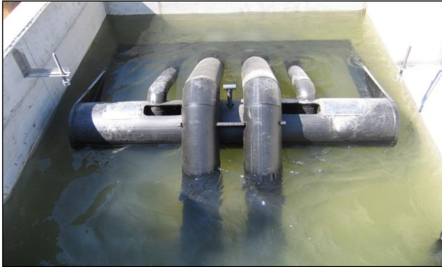
Figure 14 : Image de siphon mécanique
