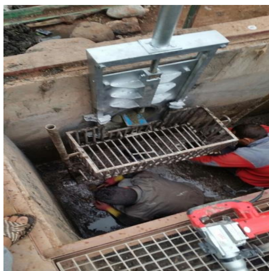
Figure 8 : Curage au fond de bassin de stockage (dégrilleur)
