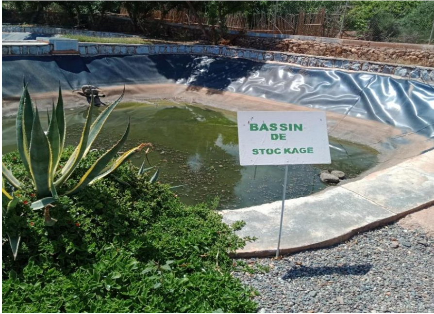
Figure 20 : Bassin de stockage Asselda
