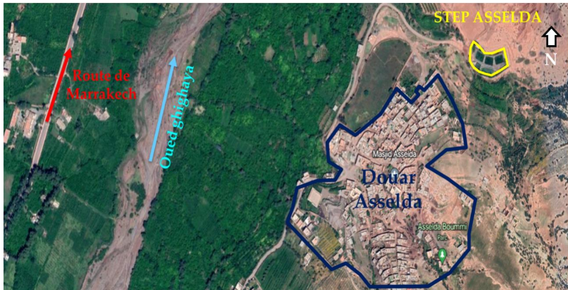
Figure 11 : Station de traitement des eaux usées ASSELDA
