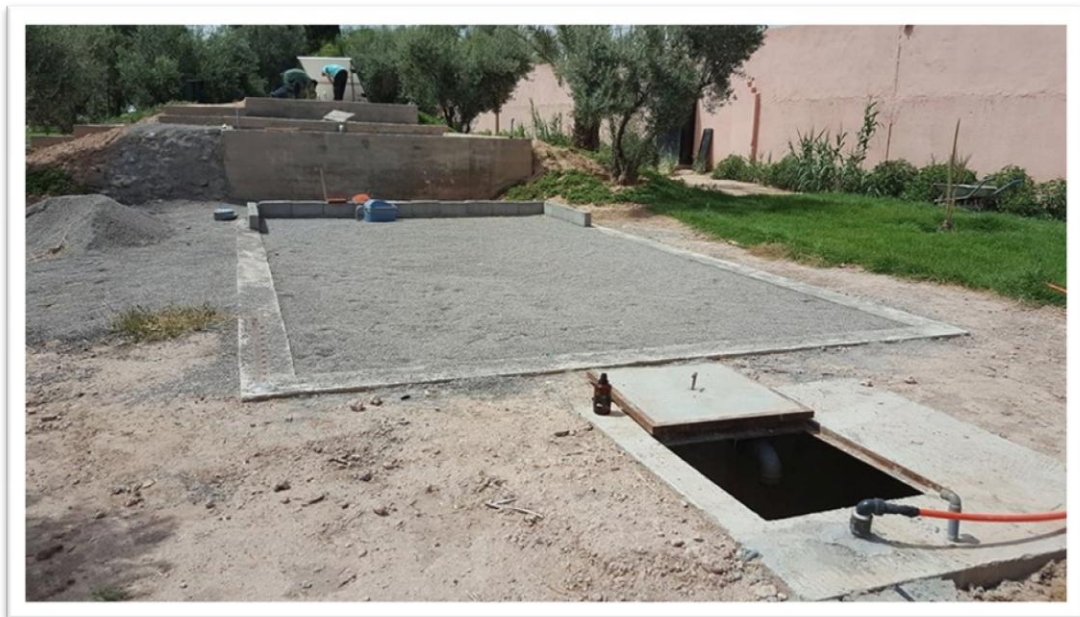
Figure 2 : Photo d'un filtre imbriqué implanté au niveau de la Faculté de Droits Université Cadi Ayyad pour le traitement des eaux usées domestiques.
