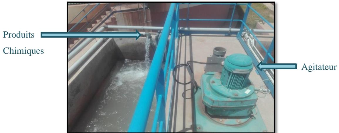
**Photo 2 : Injection des réactifs en amont des débourbeurs dans l'ouvrage de mélange rapide**
