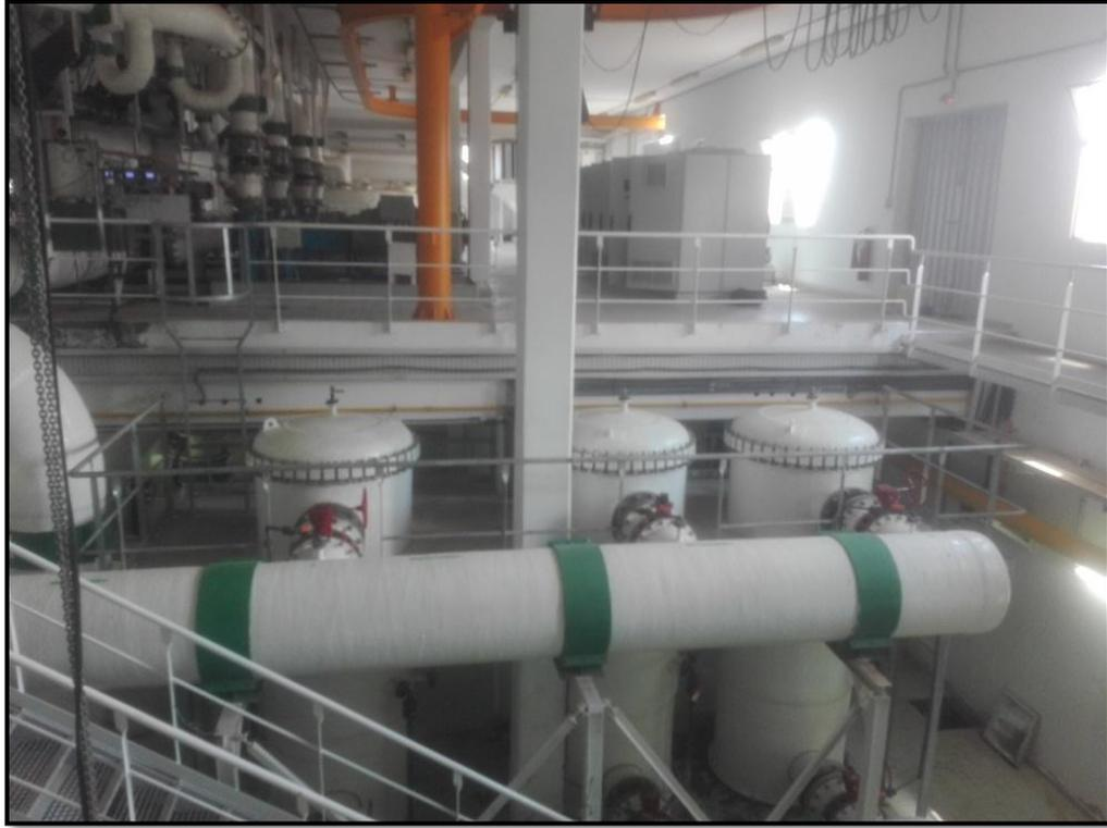
**Figure 10 : Pompes doseuses du séquestrant en amont des microfiltres**
