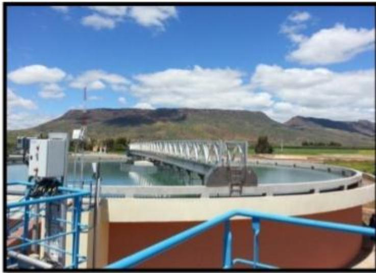
**Photo 3 : Débourbeur de la station de traitement des eaux potables de Khénifra**
