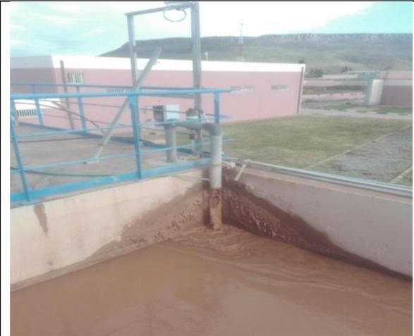
**Photo 5 : Ajout du polymère dans l'ouvrage de floculation**
