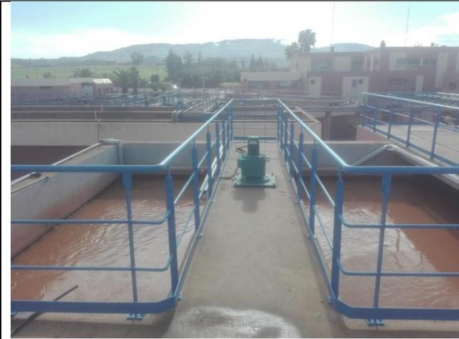
**Photo 4 : Ouvrages de floculation de la station de Khénifra**
