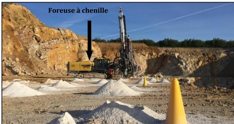
Figure24: Photo d'exécutions des Forages au niveau des formations exploitées
